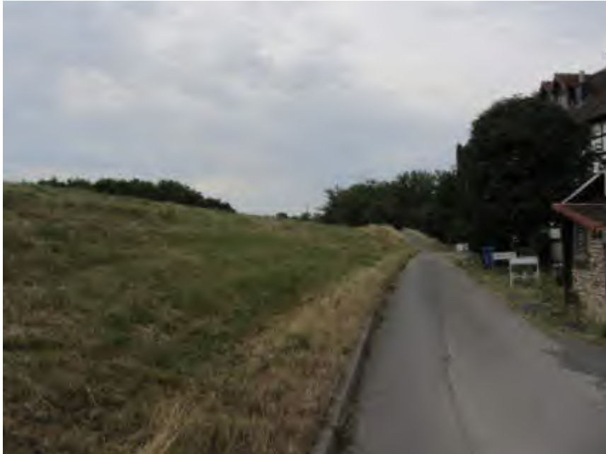
Bild 35: Schutzwall vor Überschwemmungsgebiet
