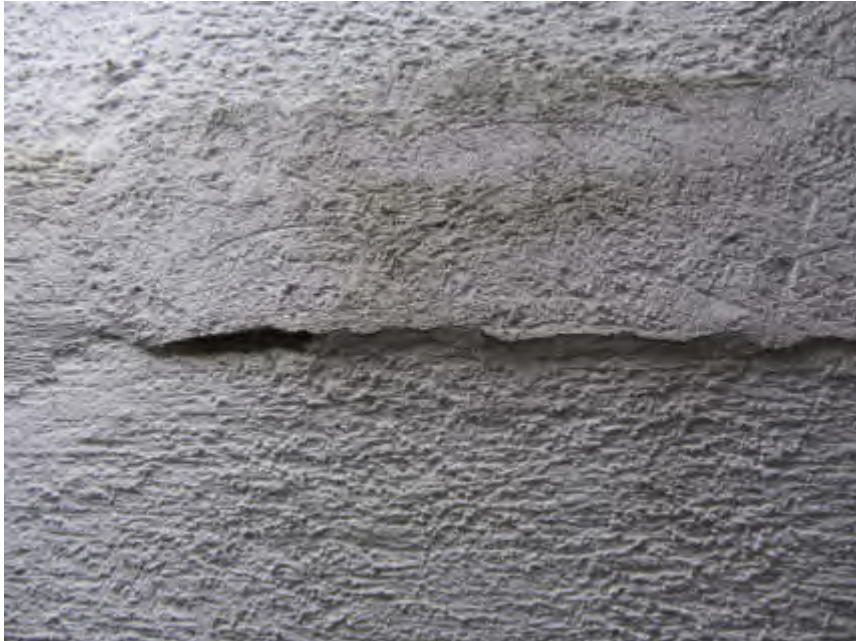
Bild 9: Putzschäden
