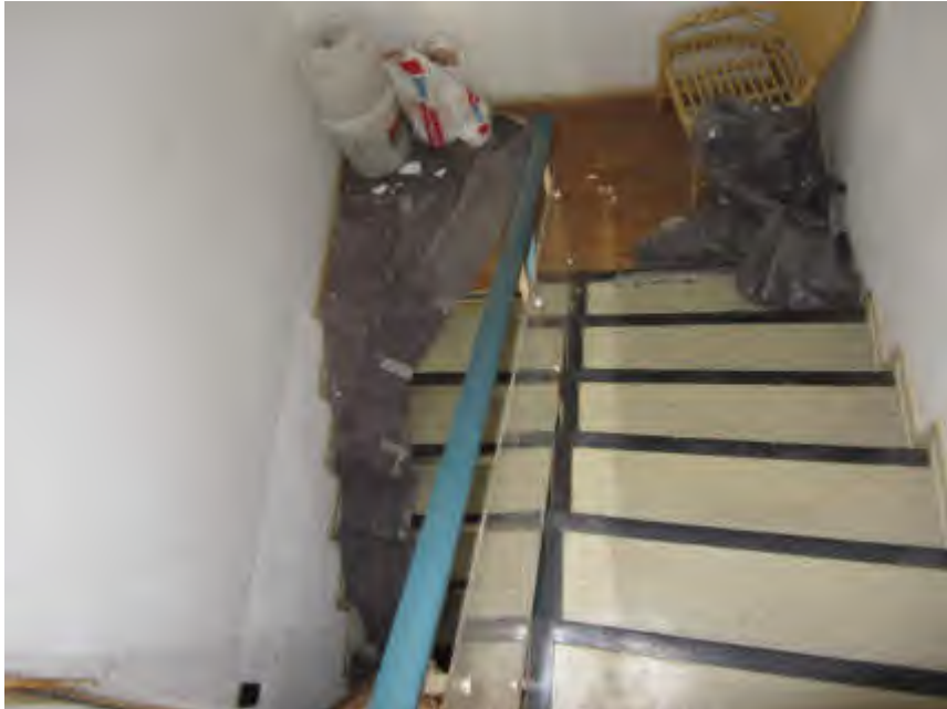
Bild 21: Treppe Erdgeschoss zu Obergeschoss
