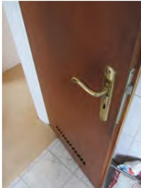
Bild 29: Obergeschoss, Zustand Innentüren
