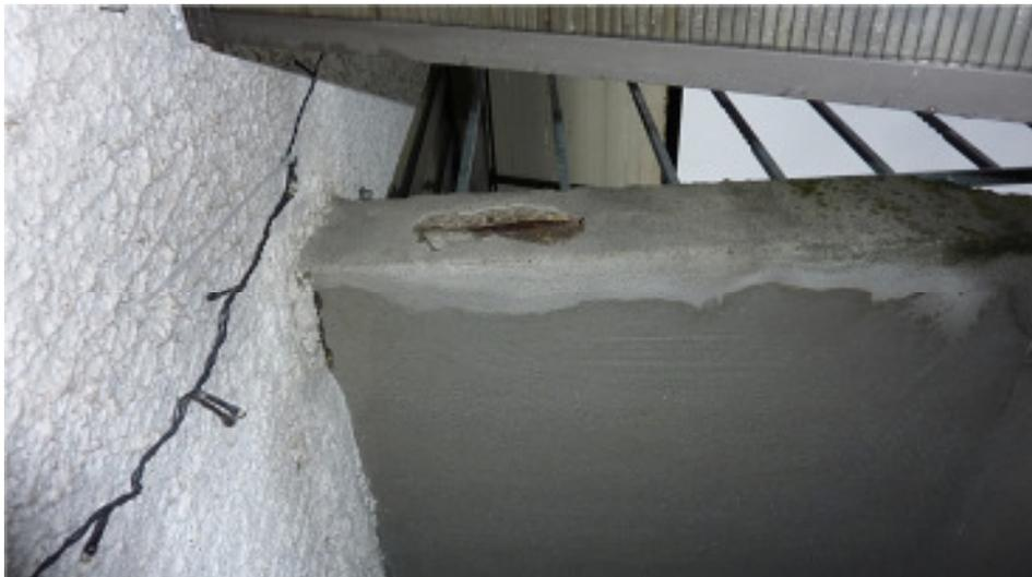
Außeneingangspodest / seidl. freilieg. korrodierte Bewehrung
