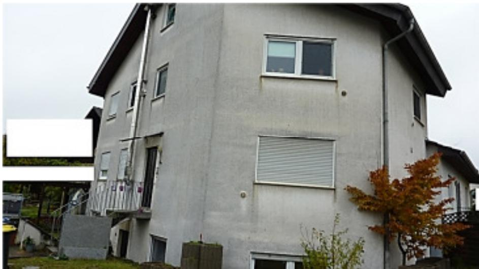
Fassade mit erheb. Abnutz.ersch. und Verschmutzungen / Kältebrücken
