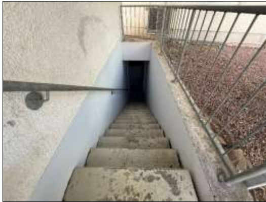
Außentreppe zur Tiefgarage
