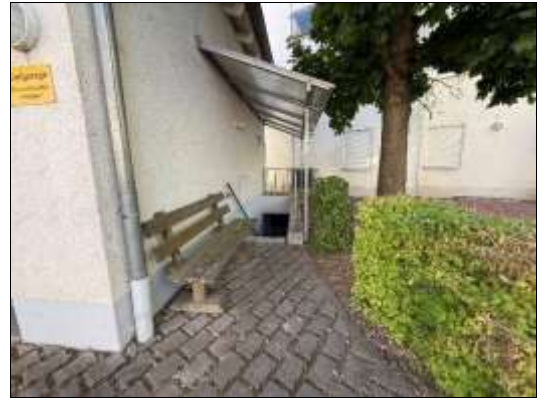
Treppe zur Tiefgarage
