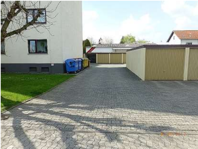
Ansicht von Osten mit Zufahrt von der Waldstraße
