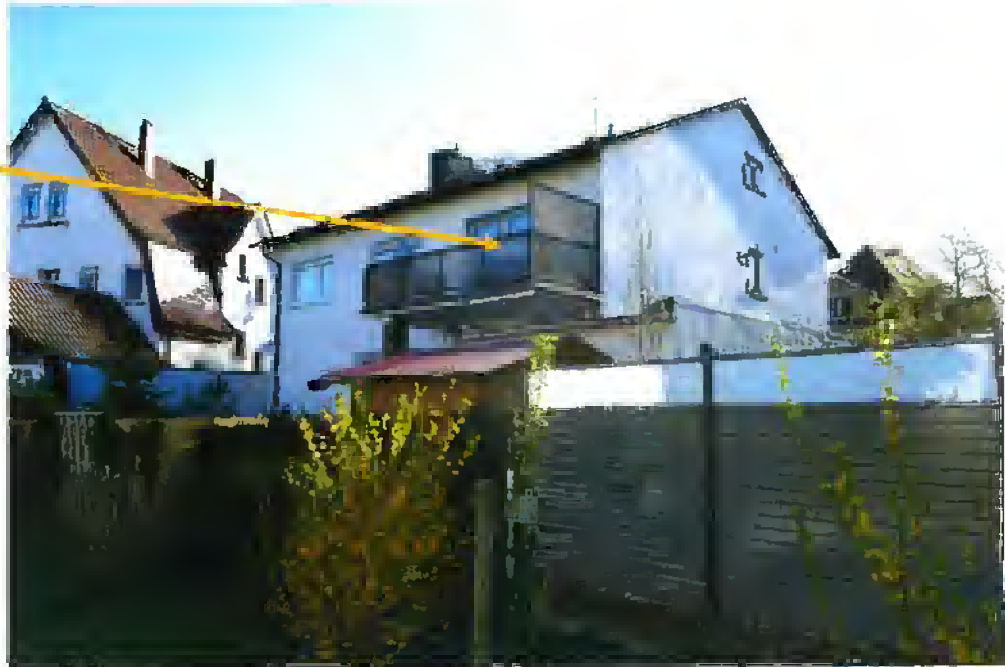
Bild 3: Rückansicht von Nord-Osten
