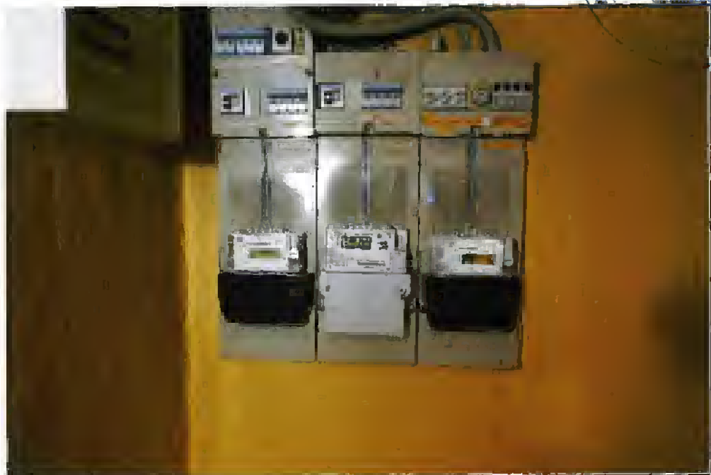
Bild 6: KG: Zählerschrank fehlt
