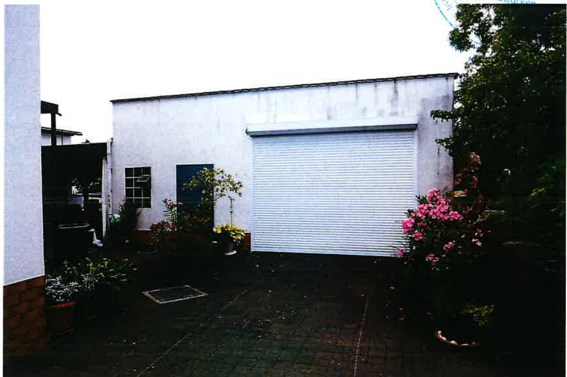
Bild 4: Ehemalige Halle (jetzt Garage und Abstellraum) an der Ostgrenze
