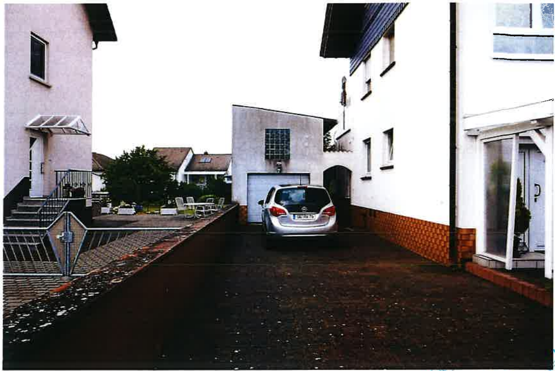
Bild 3: Garage und Abstellraum an der Westgrenze (vgl. auch Ziff. 5.12)
