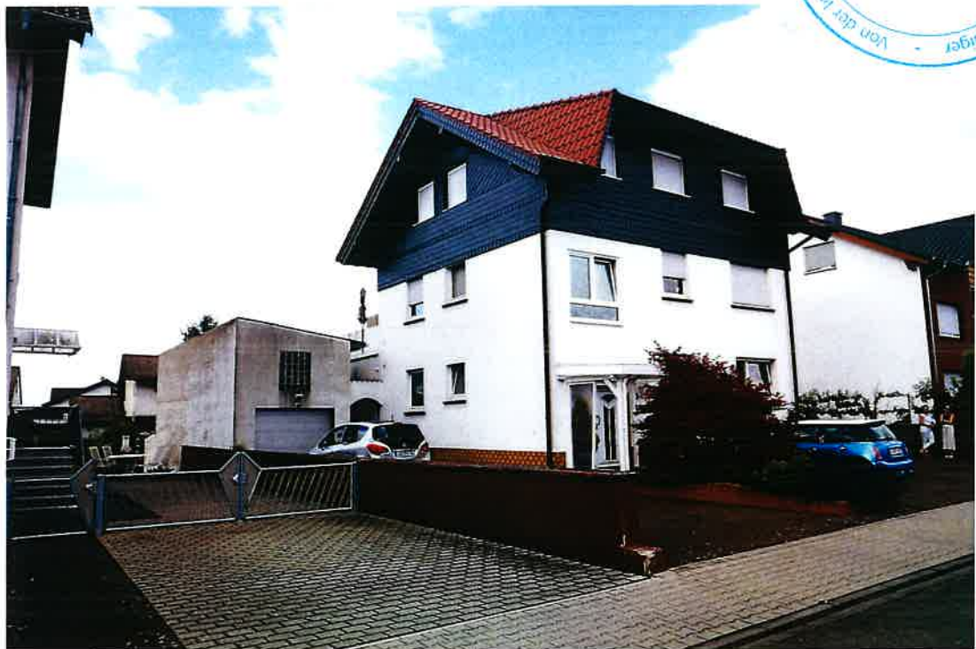
Bild 2: Ansicht von Südwesten
