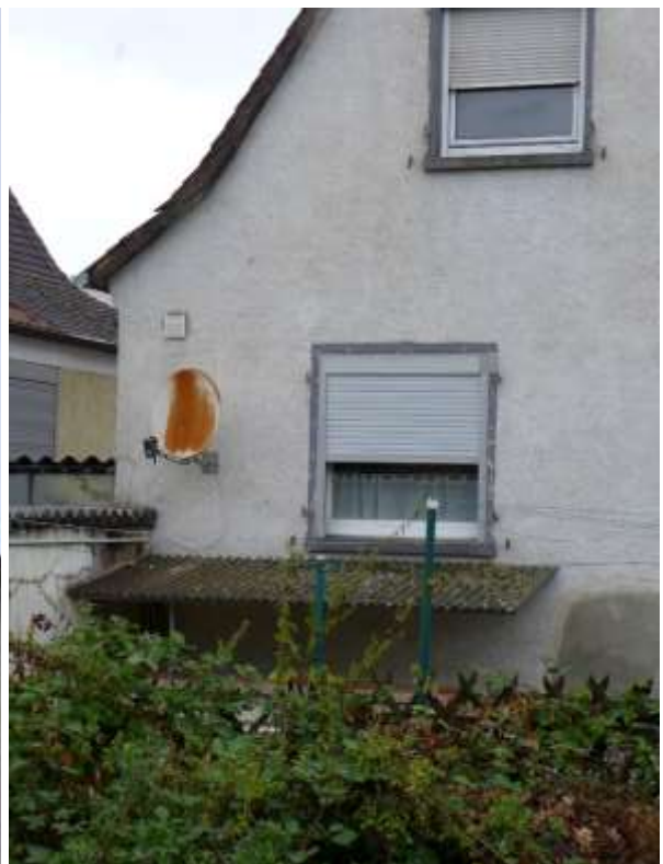
10 b Kelleraußentreppenüberdachung
