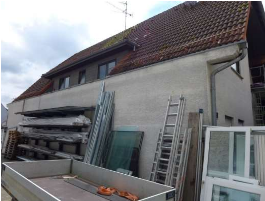
7 Nordseite, oben Dachterrasse
