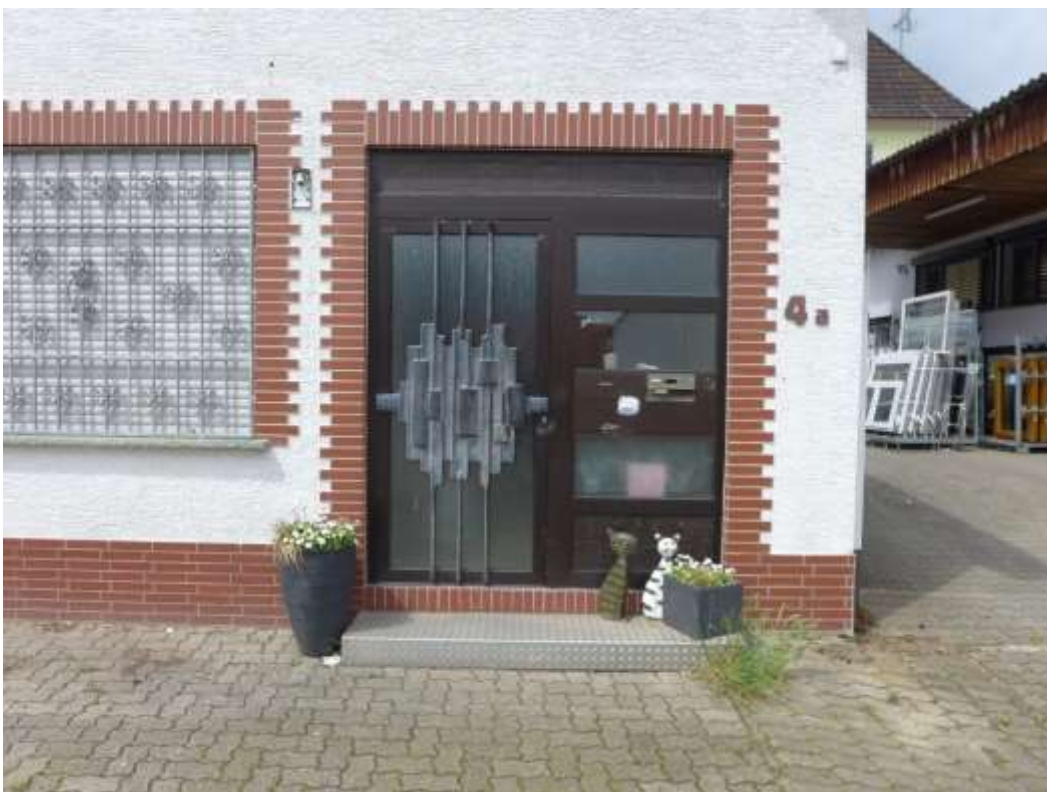
6 Eingangsbereich Haus Nr. 4a
