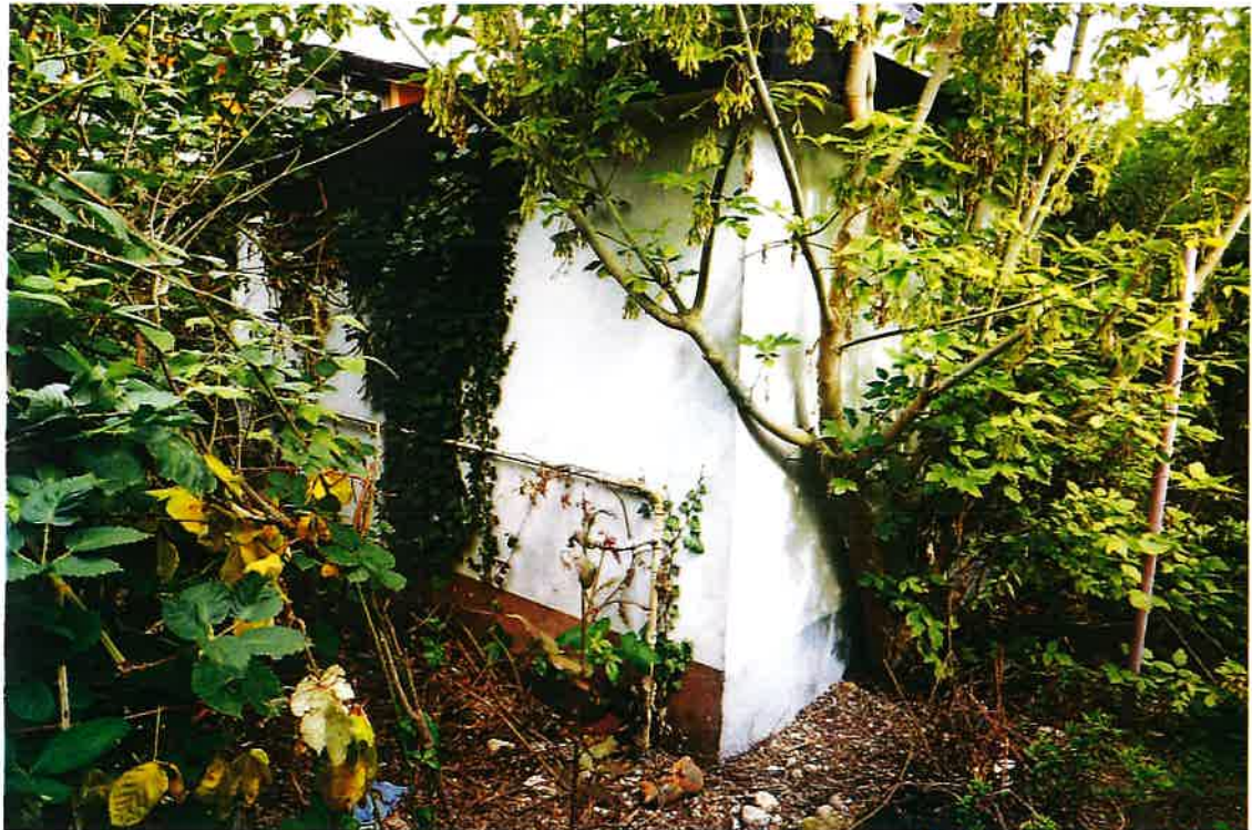
Bild 3: Blick auf das Nebengebäude (Garagenanbau)
