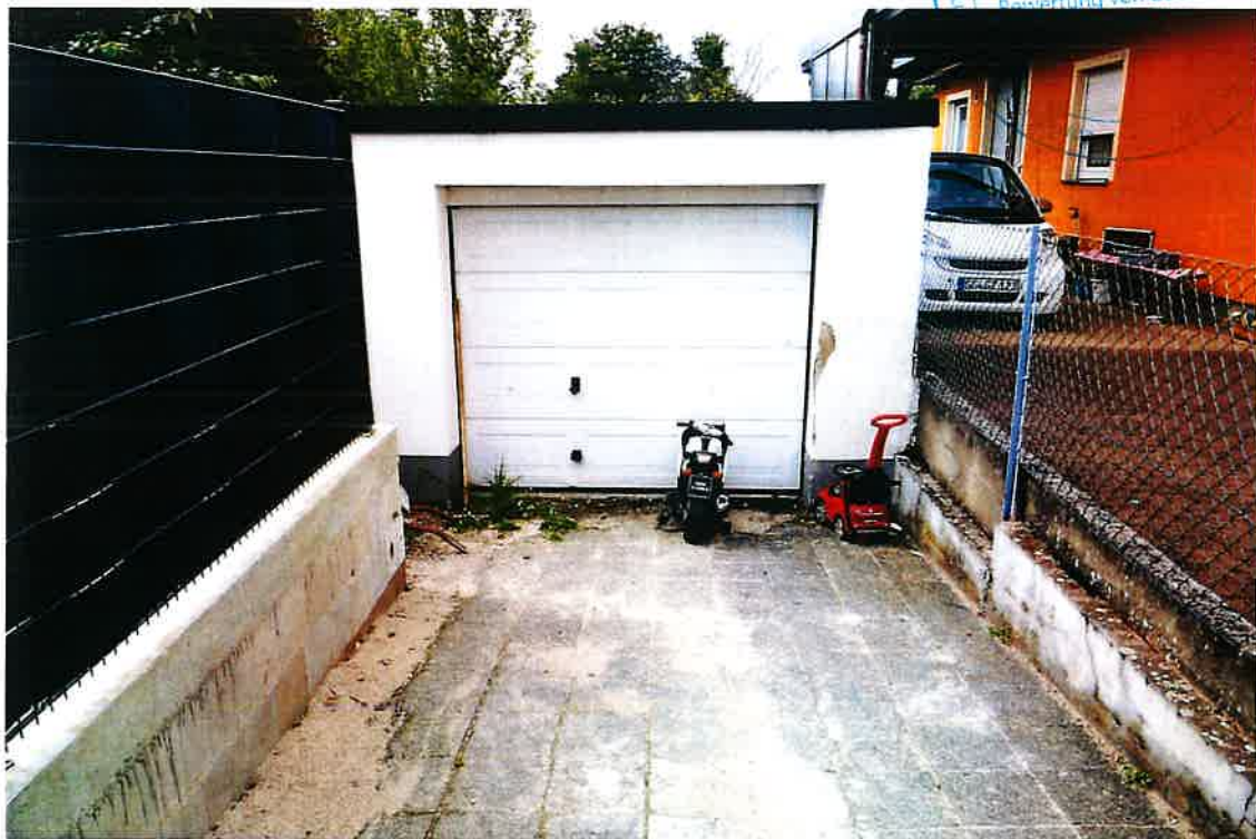
Bild 2: Blick auf die Garage von Osten
