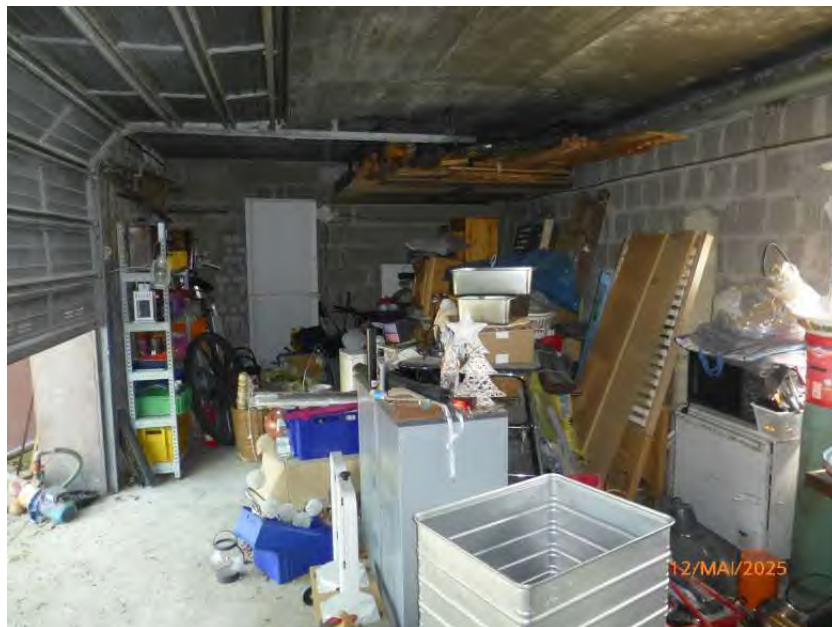
Lager unter Kegelbahn
