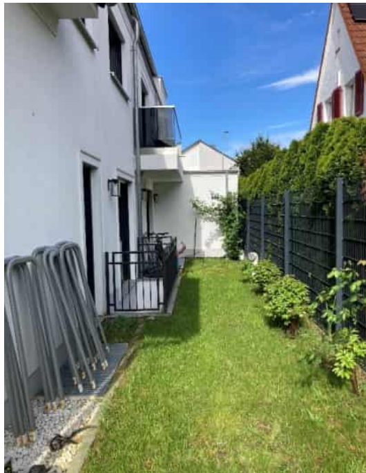
Fassade mit Lichtschächten Nordseite
