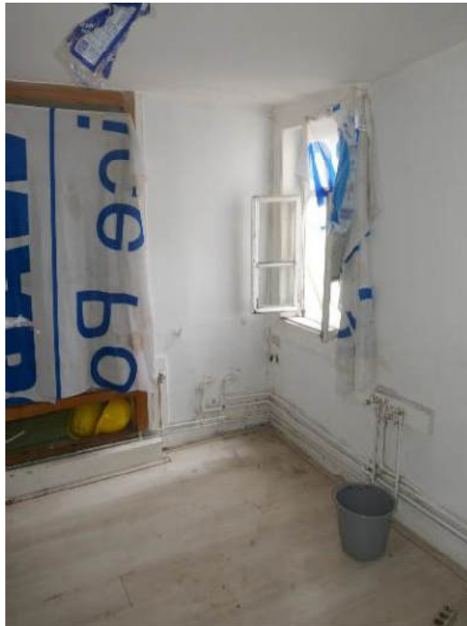
Verteilerflur im 2. OG (Bereich ehemaliger Gästezimmer)
