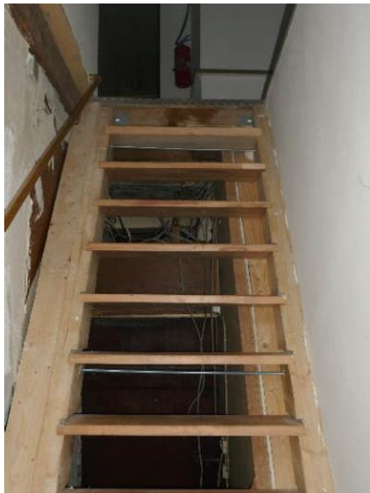
provisorischer Treppenneubau zum OG
