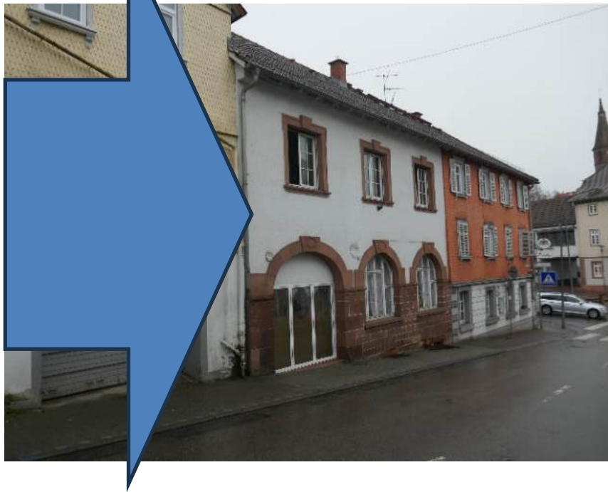
Seitenansicht (Gammelsbacher Straße)
