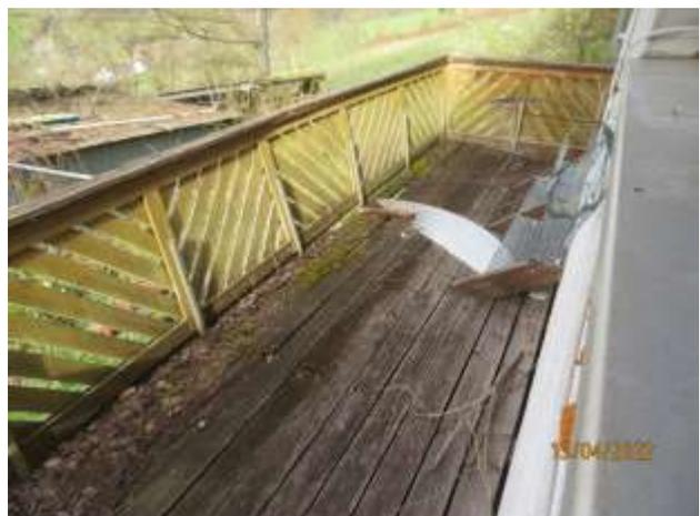
**Bild 20: Teilansicht eines schadhaften Balkons**
