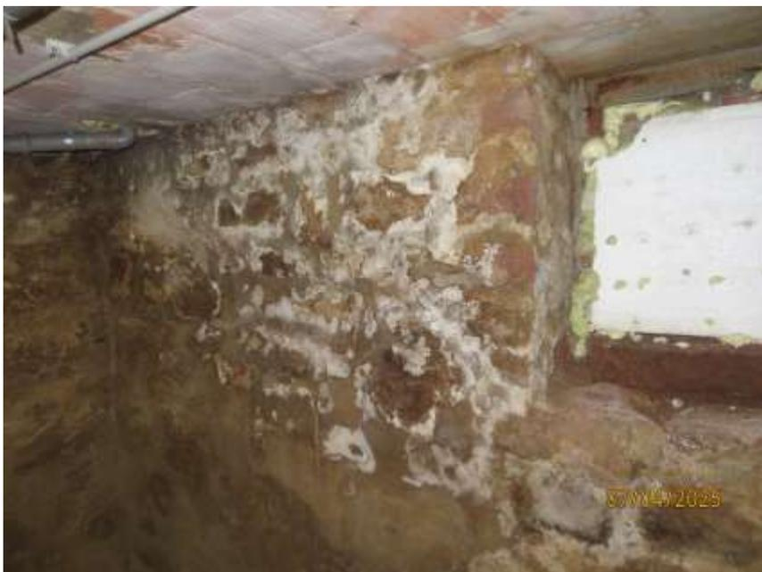
**Bild 18: Teilansicht Feuchteschäden, eventl. Hausschwamm**
