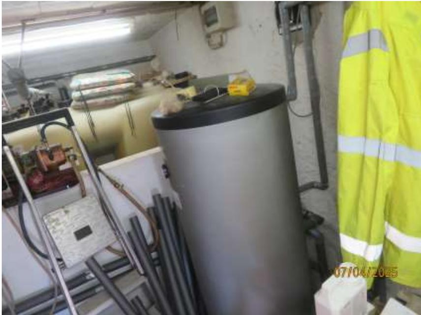
**Bild 15:** Teilansicht Warmwasservorlagebehälter, im Hintergrund die Tankanlage
