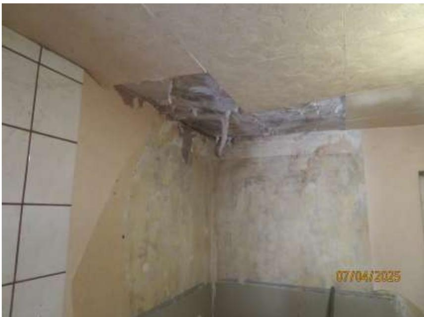
**Bild 24:** Teilansicht (laut Angabe sanierter Wasserschaden in der Küche)
