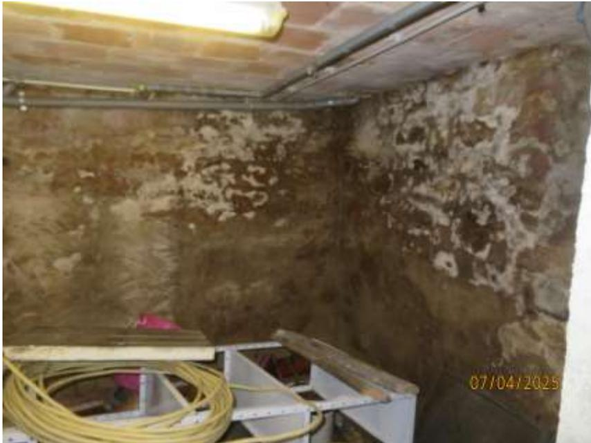
**Bild 17: Teilansicht Feuchteschäden, eventl. Hausschwamm**
