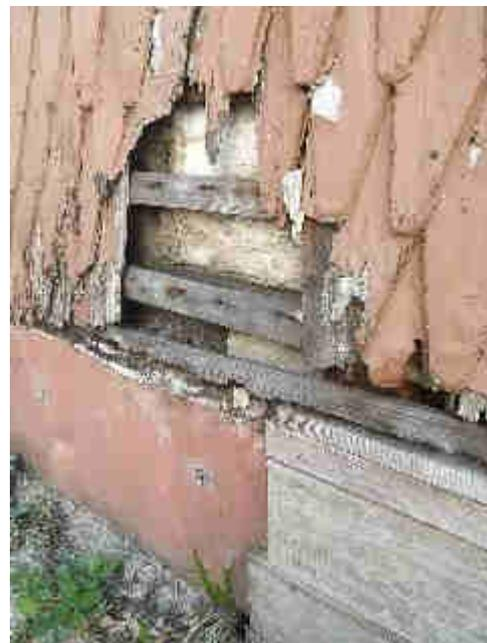
Bild 10: Bauschäden an der Schindelfassade
