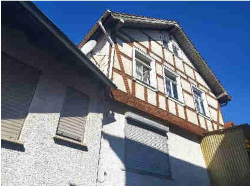
Bild 3: Zwerchgiebel im Dachgeschoss (Bauteil 2)
