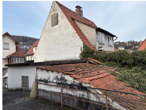
Südwestansicht Wohnhaus u. Garage
