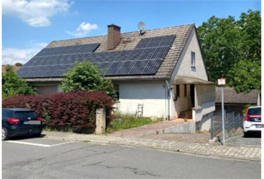
Foto 1 des SV: Ansicht von Süden, von der Straße Im Bangert; Anonymisierungen d.d. SV
