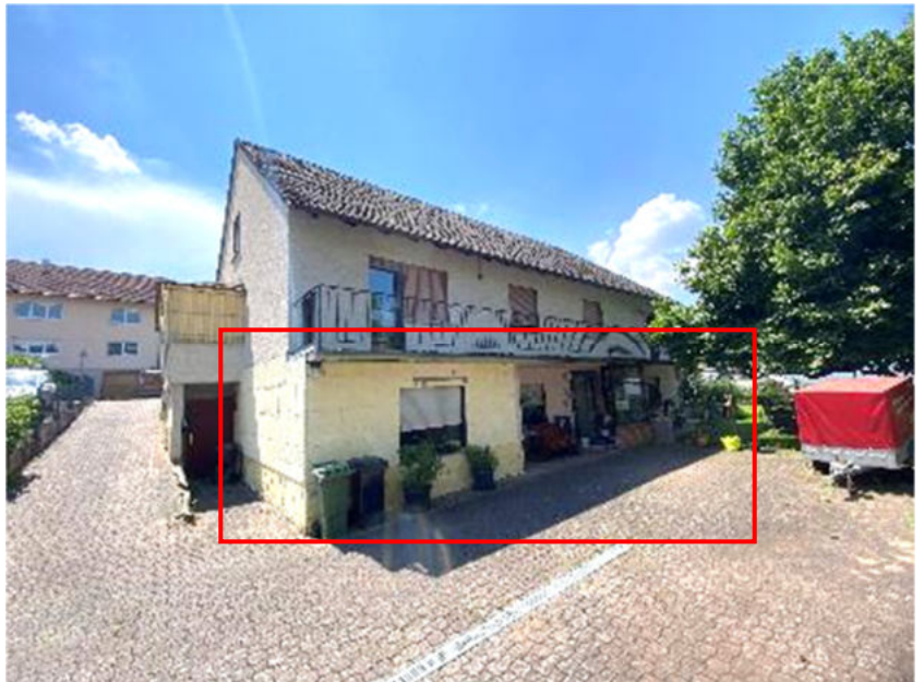
Foto 2 des SV: Ansicht von Nordosten, Hausrückseite; Detail Wohnung Nr. 2; Roteintragung d.d. SV
