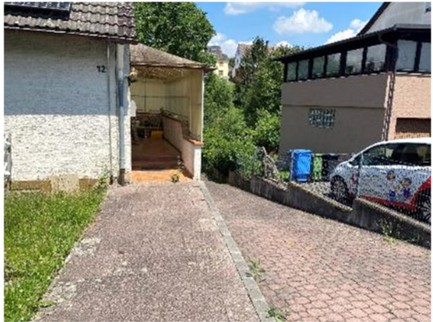
Foto 5 des SV: Eingangsbereich/Zugang EG; Hofeinfahrt/Zugang UG
