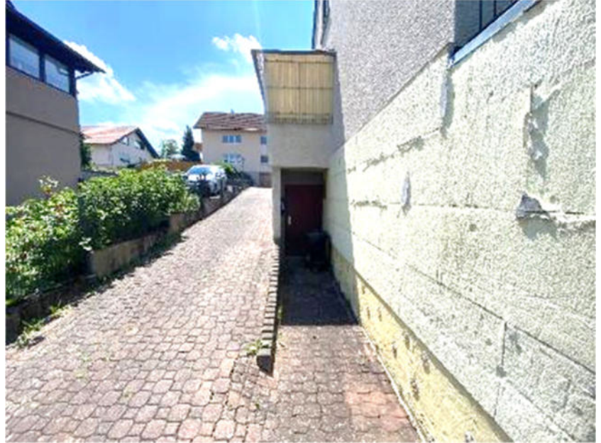
Foto 7 des SV: Ansicht von Norden; Eingangsbereich Gemeinschaftsräume im UG
