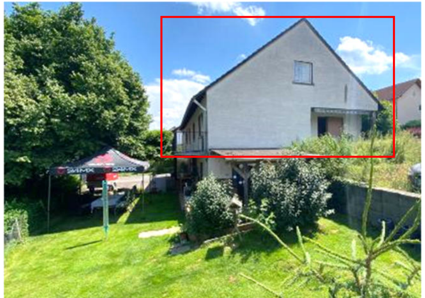
Foto 4 des SV: Ansicht von Nordwesten; Detail: Wohnung Nr. 1; Roteintragung d.d. SV
