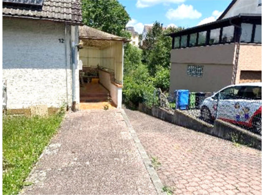
Foto 5 des SV: Eingangsbereich/Zugang EG, Wohnung Nr. 1; Hofeinfahrt
