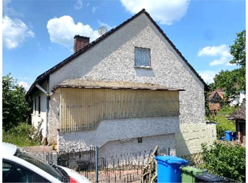
Foto 3 des SV: Ansicht von Südosten
