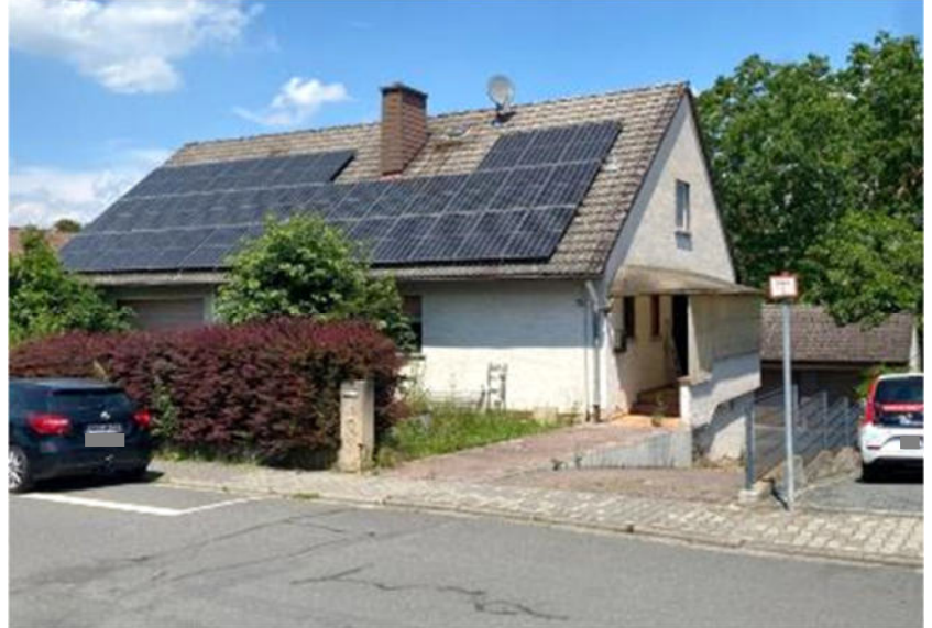
Foto 1 des SV: Ansicht von Süden, von der Straße Im Bangert; Anonymisierungen d.d. SV
