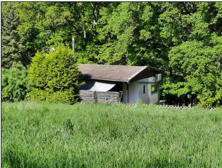
Abb. 3: Blick auf Wohnhaus von Nordosten
