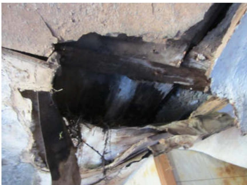
Bild 24: 1.Obergeschoss: Loch im Deckenbereich
