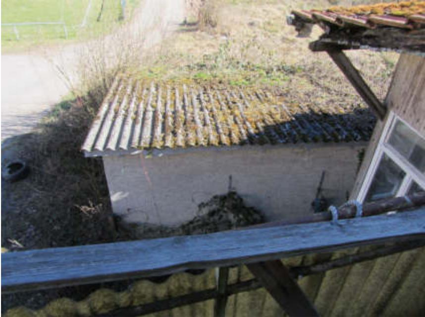
Bild 21: Dacheindeckung der Garage vermutlich asbesthaltig
