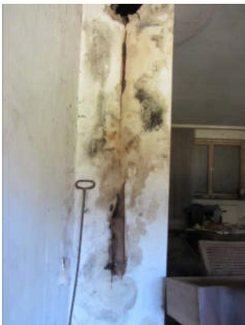
Bild 30: Erdgeschoss: Schimmelpilz vorhanden
