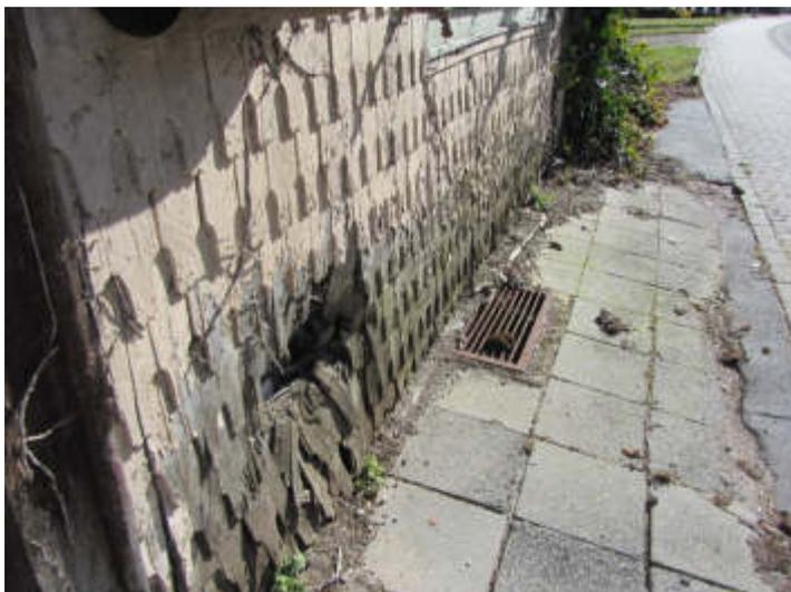
Bild 8: Zustand Holzverkleidung der Fassade
