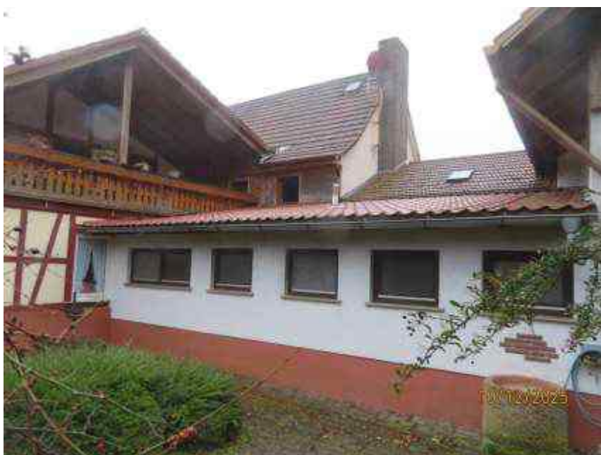
Bild 17: Teilseitenansicht / Toilettenanlage Einheit 2
