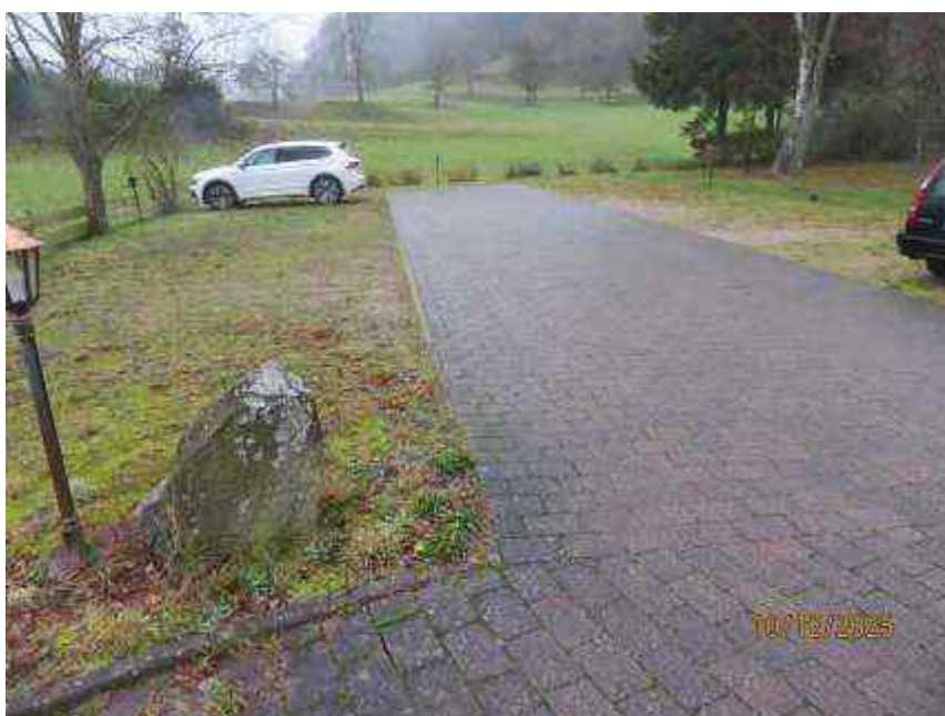
Bild 26: Teilansicht zu der Parkplatzfläche auf Flurstück 65
