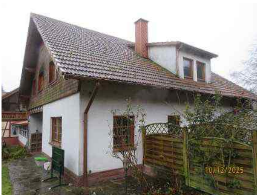
Bild 15: Teilseiten-/Rückansicht (Gebäudeteil Einheit 1)
