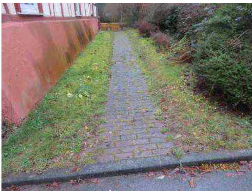
Bild 22: Teilansicht Zugangsbereich zu Einheit 1
