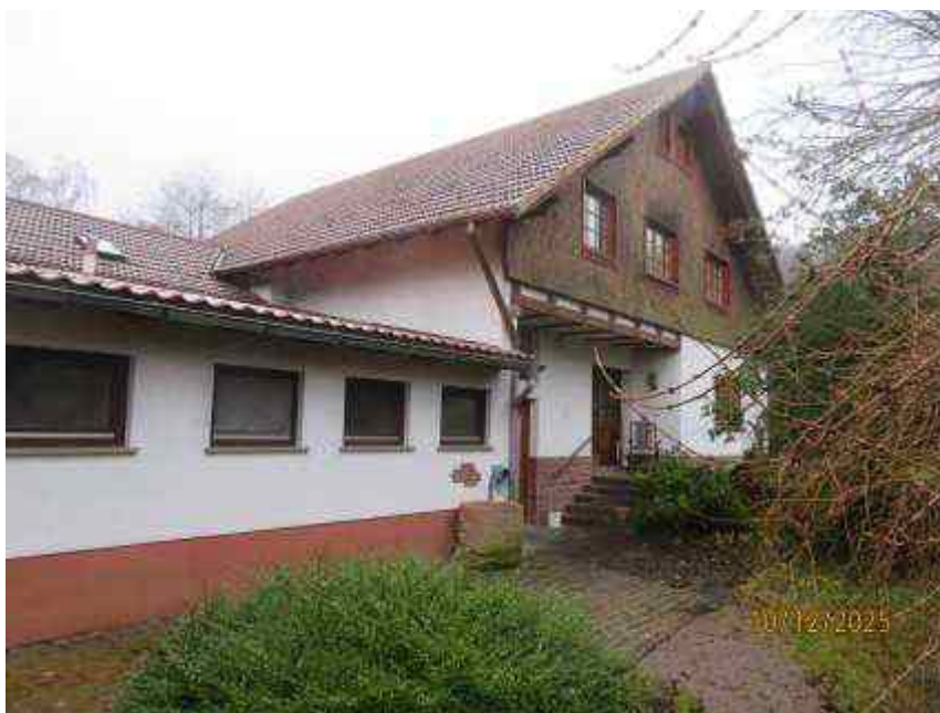
Bild 16: Teilseitenansicht (Gebäudeteil Einheit 1)
