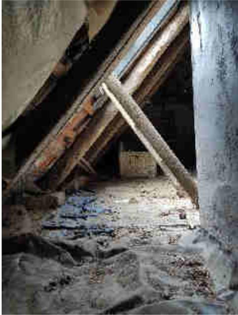
Bild 15: ungedämmte Abseiten am Dachgeschosszimmer
