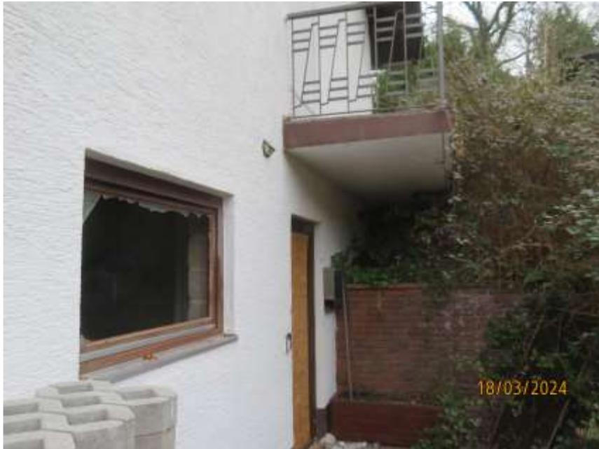
**Bild 7:** Teilansicht zu dem Eingangsbereich mit Notverglasung und eingeschlagener Scheibe zu der Garage
