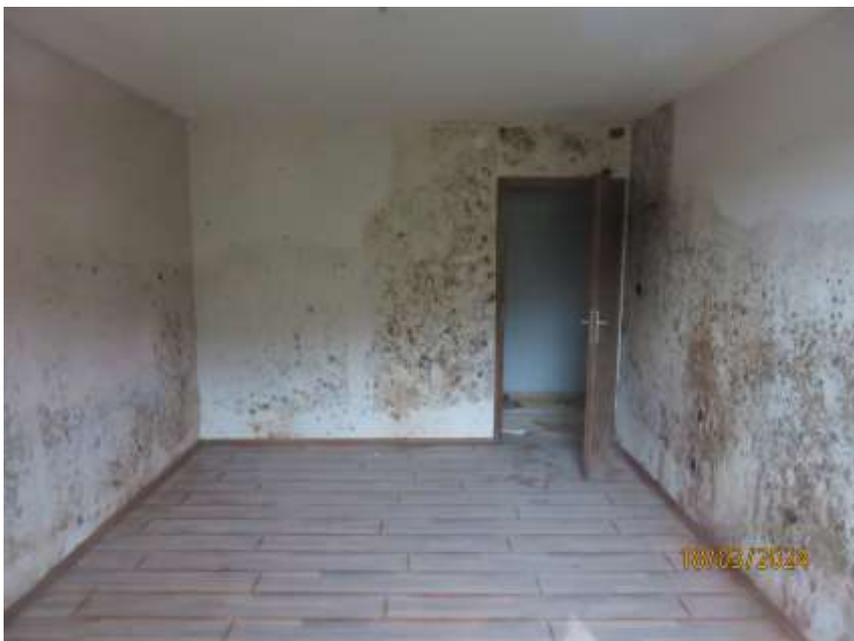
**Bild 16:** Teilansicht des Zimmers in der Nordwestecke im Untergeschoss mit Schimmel/Wasserschaden (Bild von außen durch ein Fenster gefertigt)
