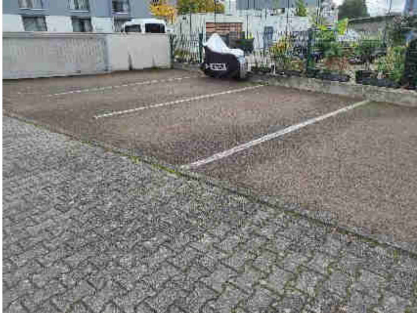
Bild 5: Stellplatzfläche (und Baulastfläche) auf Flst. 269/37
