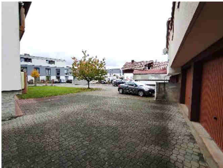
Bild 6: Hoffläche zwischen dem MFH und den Garagen Flst. 269/36
