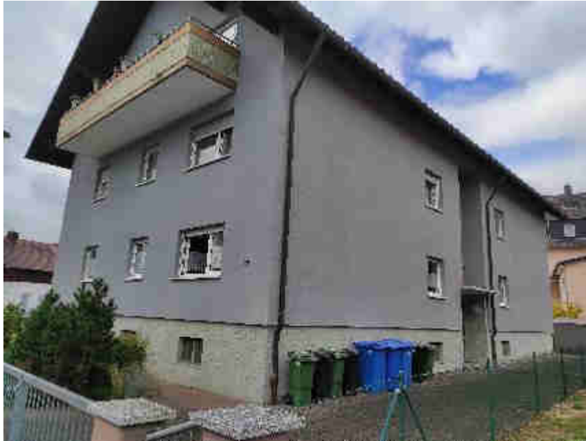
Bild 1: Ansicht des Mehrfamilienhauses zur Straße
