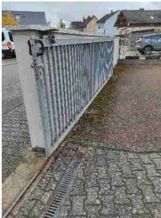
Bild 12: Schiebetor an der Hofeinfahrt
