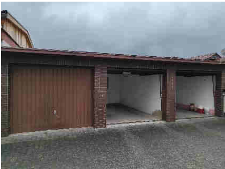
Bild 4: OG des Garagengebäudes Flst. 269/37; Zufahrt v. Grundstück Flst. 269/38
