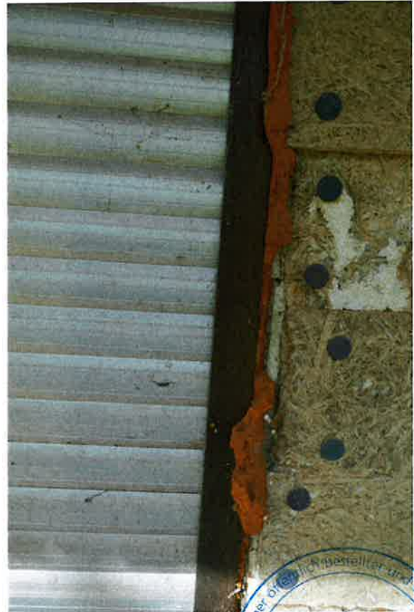
Bild 5: Fensteranschlüsse z. T. mangelhaft
