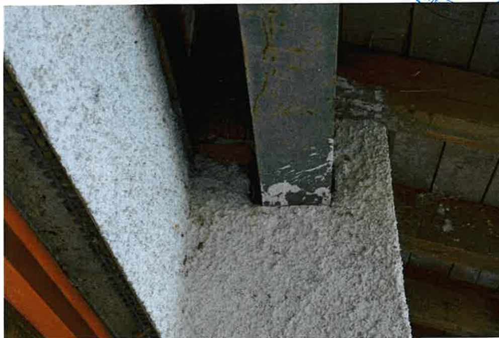
Bild 8: Detail zu Bild 7 - erhebliche Wärmebrücke
