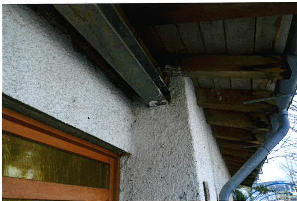
Bild 7: Stahlträger aussen über Eingang ohne Bekleidung (WD)
