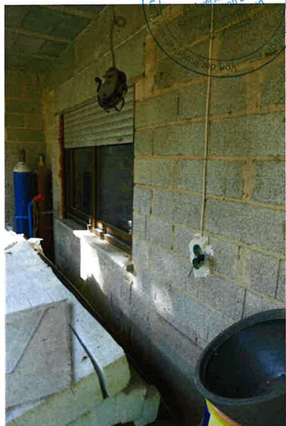
Bild 4: Außenputz fehlt z. T. (KG talseitig)
