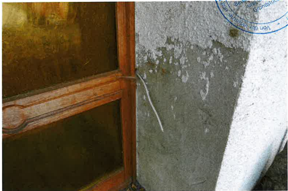
Bild 6: Außenputz z. T. defekt
