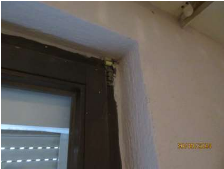
Bild 29: Teilansicht fehlender Gurtwickler zum Rollladen, stellvertretend für Weitere
