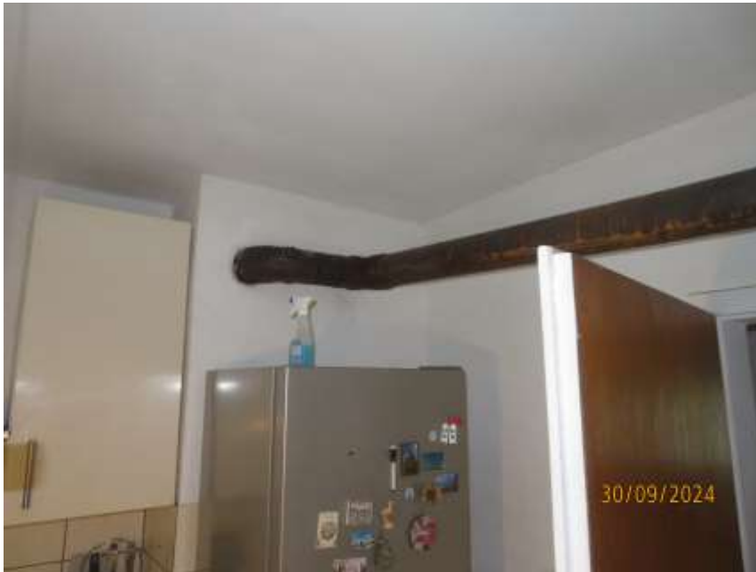
Bild 21: Teilansicht der Küche / Ofenrohr unter der Decke
