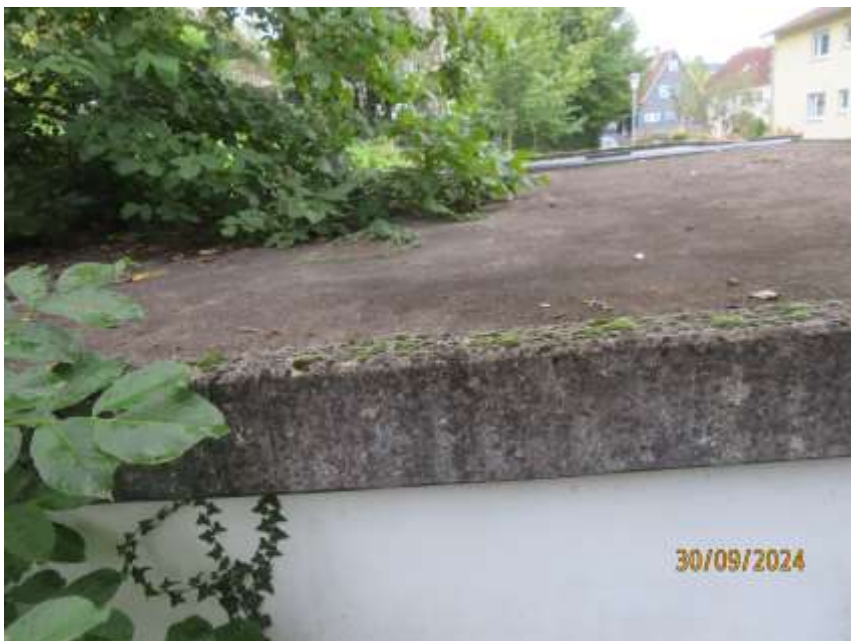
Bild 4: Dachaufsicht zu der Garage
