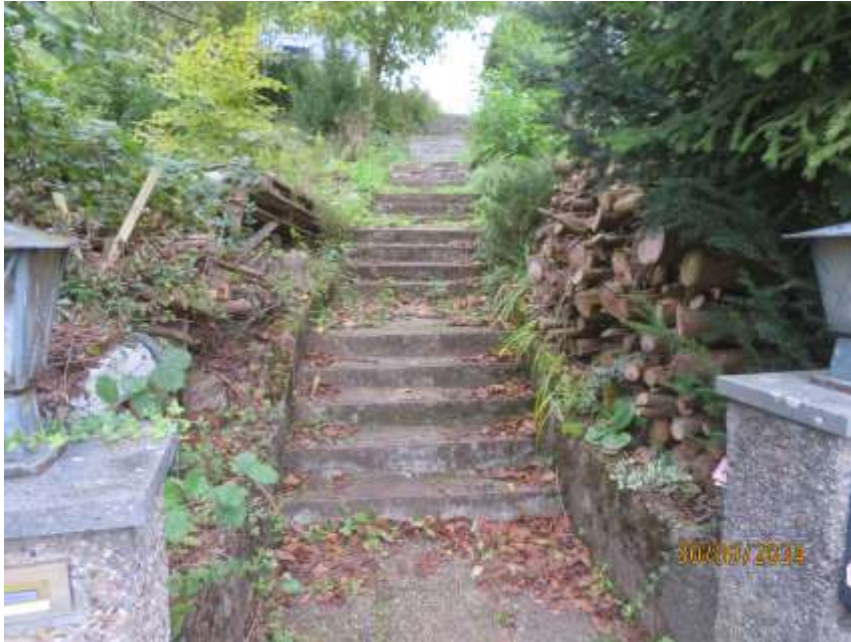
Bild 7: Teilansicht des Treppenaufgangs von der Straße zum Wohnhaus
