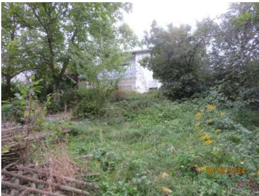
Bild 14: Teilansicht der Außenanlage
