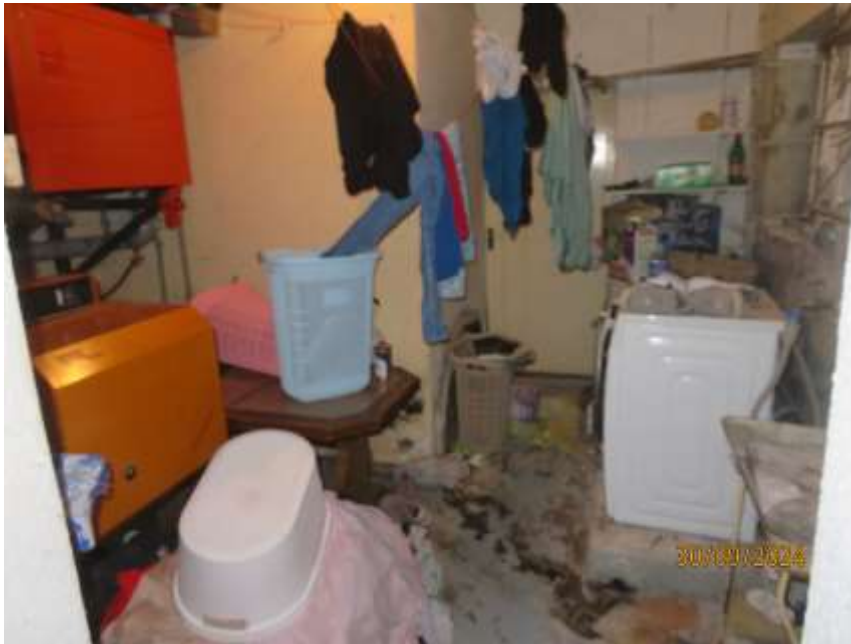
Bild 27: Teilansicht des Heizungs-/Waschraumes
