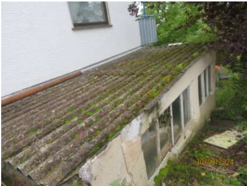
Bild 10: Teilansicht / Dachaufsicht zu dem seitlichen Schuppen
