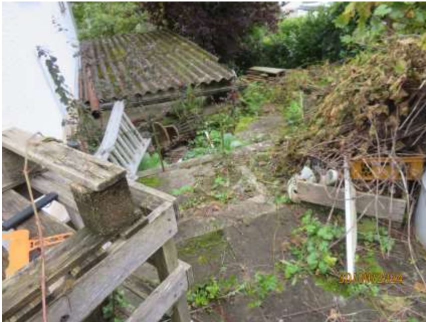
Bild 11: Teilansicht / Dachaufsicht zu dem seitlichen Schuppen
