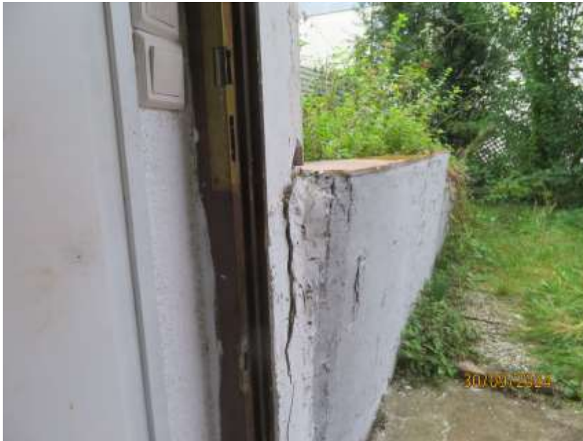
Bild 13: Teilansicht der Stützmauer neben dem Eingang zum Untergeschoss
