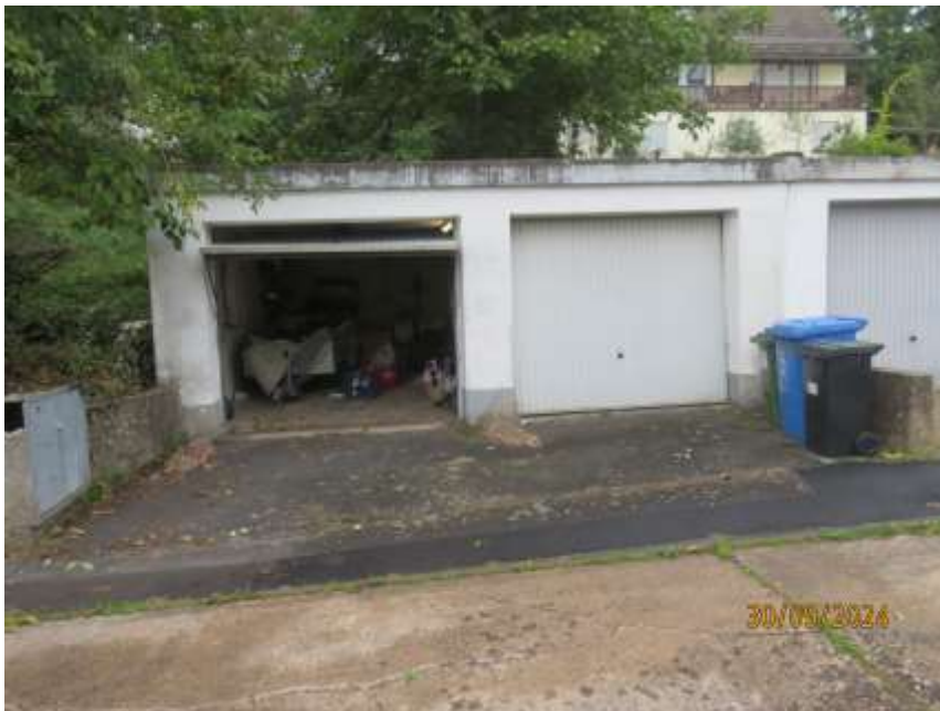
Bild 2: Straßenansicht der Doppelgarage
