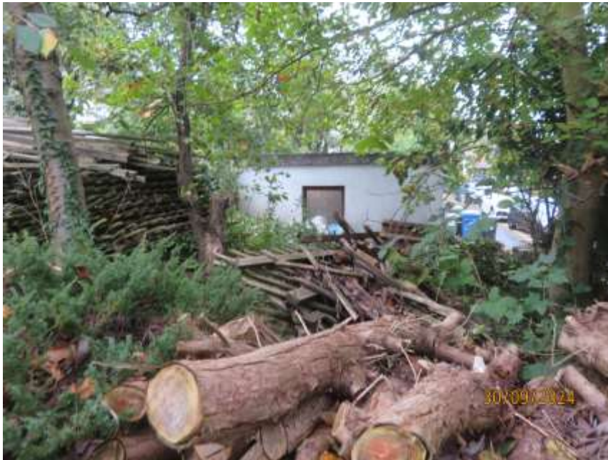
Bild 3: Seitenansicht der Garage
