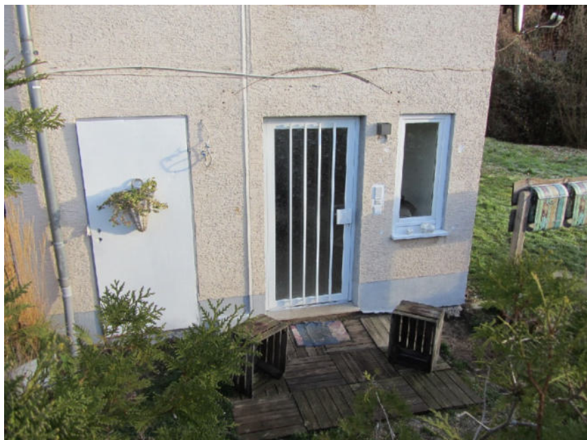
Bild 6: Nebeneingang im Erdgeschoss
