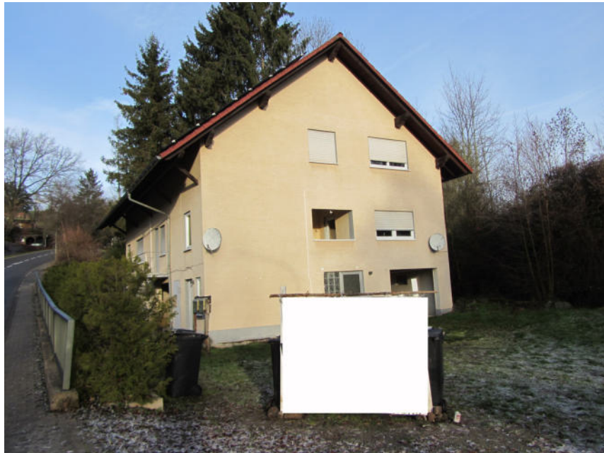
Bild 5: Ansicht Süd mit Grundstückszufahrt (fehlende Einfriedung)
