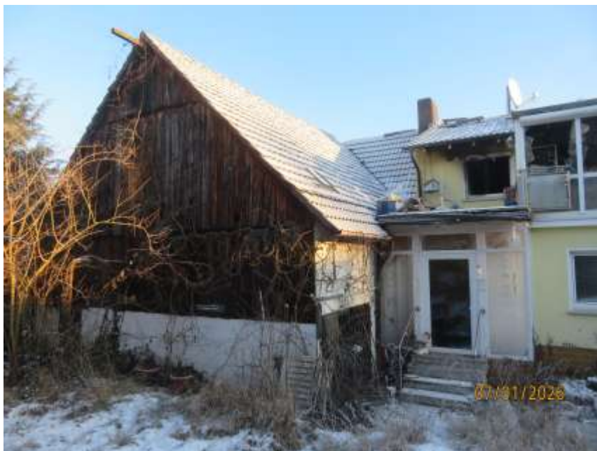
Bild 6: Teilrückansicht Wohnhaus / Scheune
