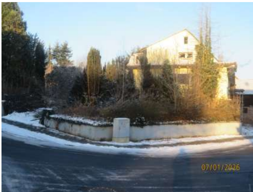
Bild 3: Teilstraßenansicht „Zum Pitschgrund“ / „Kreuzstraße“
