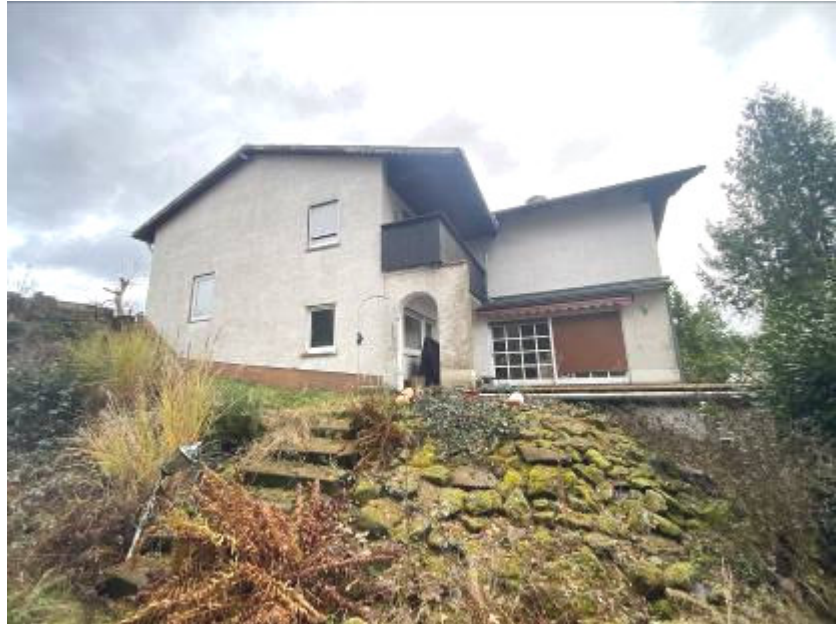
Foto 3 des SV: Ansicht von Westen
