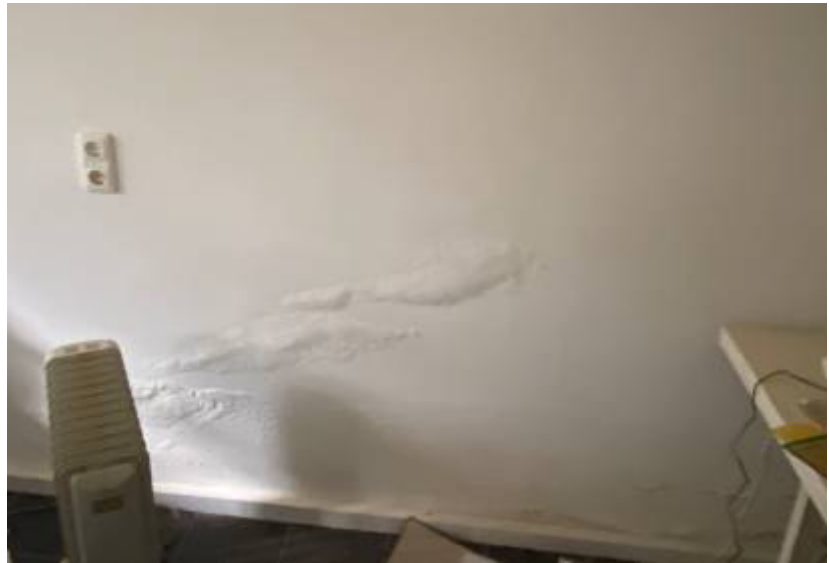
Abb. 5: Foto des SV; z.T. Feuchteschäden in Wandbereichen (Hobbyraum)
