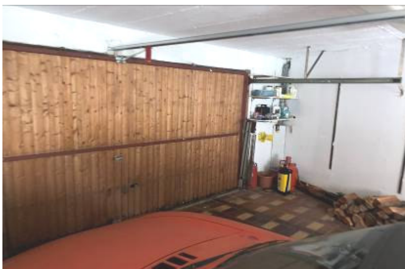
Foto 10 des SV: EG; Garage
