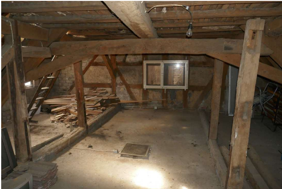
Bild 15: Dachstuhlbereich des Fachwerkgebäudes
