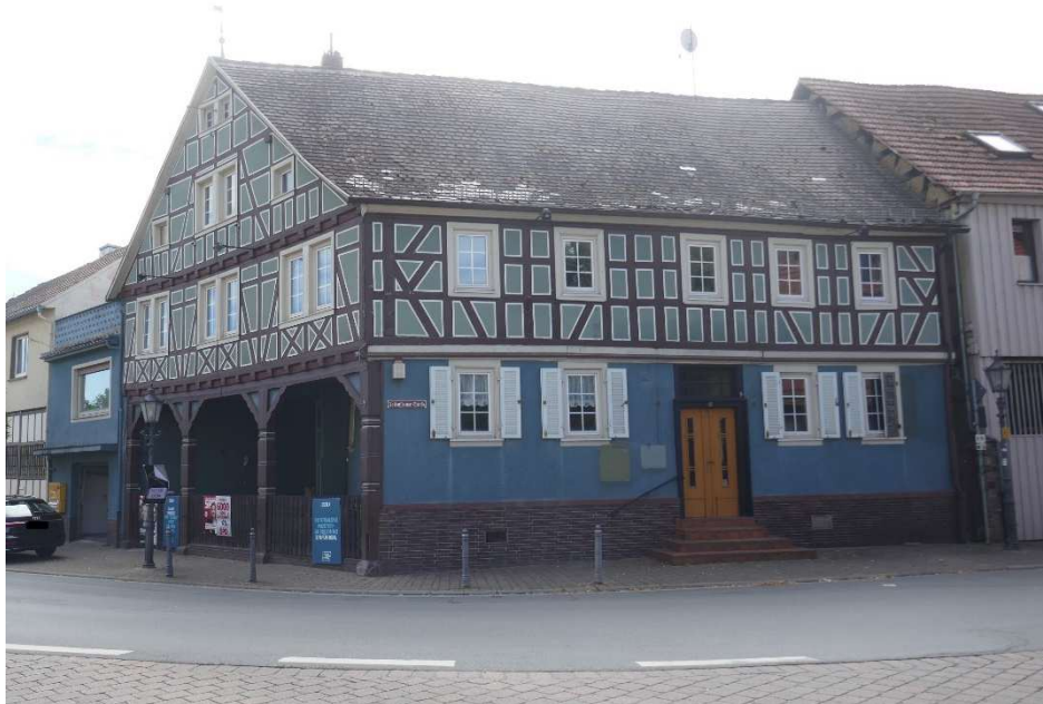
Bild 1: Gebäudeansicht von Norden
