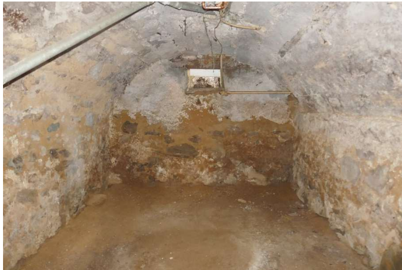
Bild 19: Gewölbekellerbereich im Fachwerkgebäude
