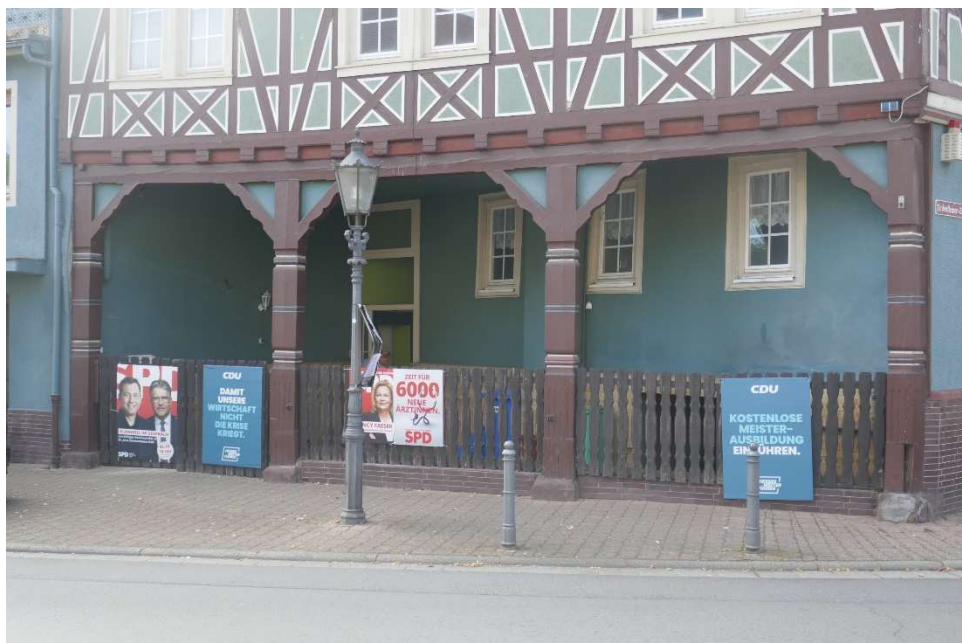
Bild 2: Eingangsbereich (links) mit Ansicht von Nordosten
