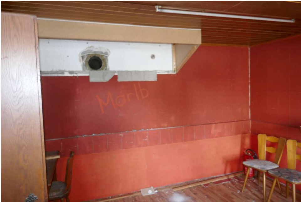
Bild 7: ehemaliger Gaststätten-Küchenbereich im Erdgeschoss
