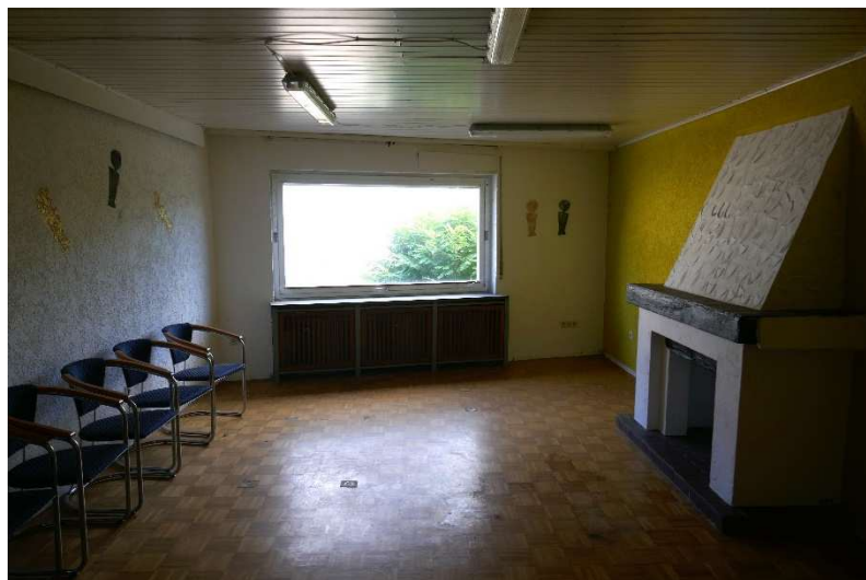
Bild 10: Wohnbereich im 1. Obergeschoss des Anbaus
