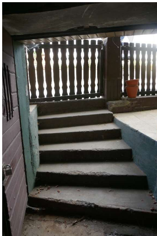
Bild 18: Aussentreppe in den Kellerbereich
