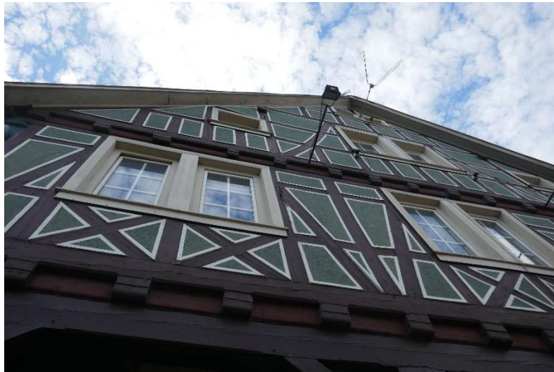
Bild 17: Fachwerkfassade auf der Gebäude-Ostseite
