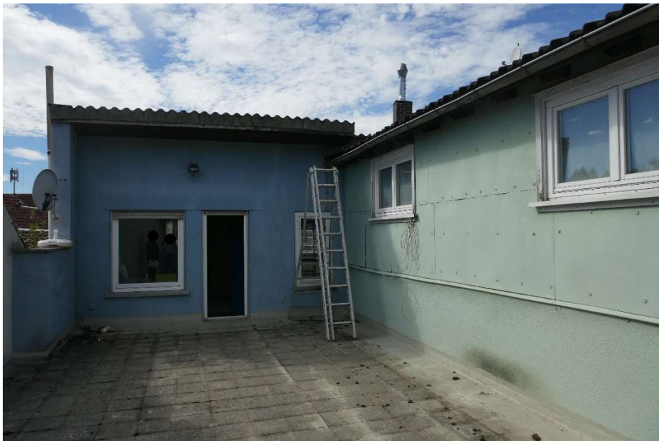
Bild 14: Dachterrassenbereich im 2. Obergeschoss des Anbaus
