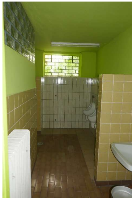
Bild 4: Toilettenanlage im Erdgeschoss (früherer Gaststättenbereich)
