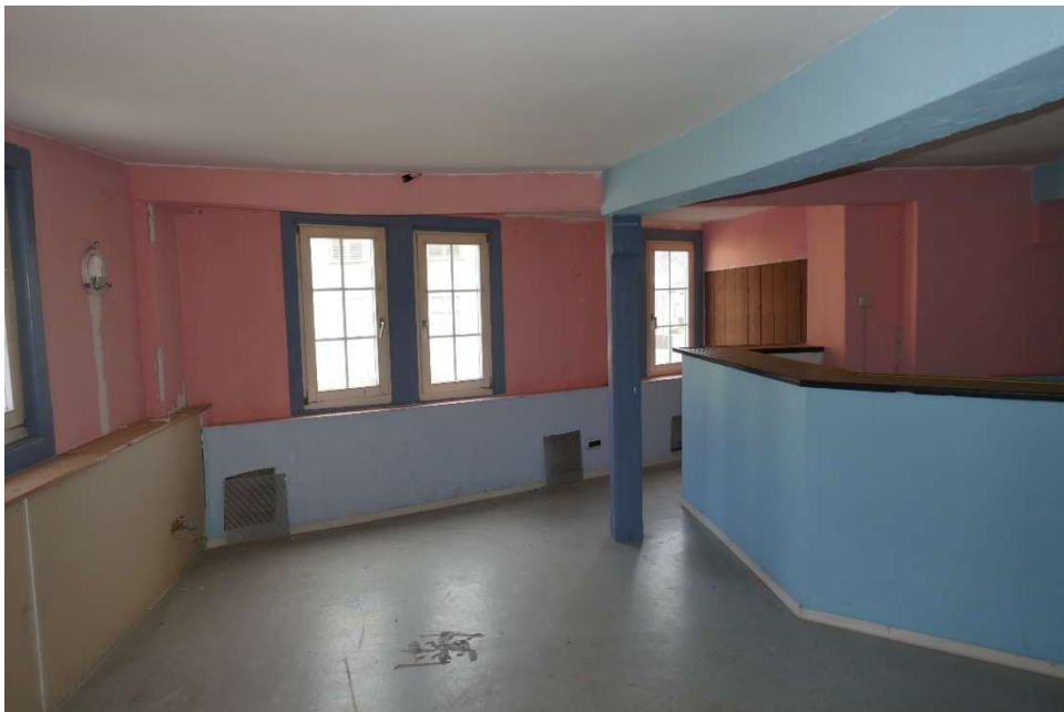
Bild 8: ehemaliger Gaststättenbereich im Obergeschoss
