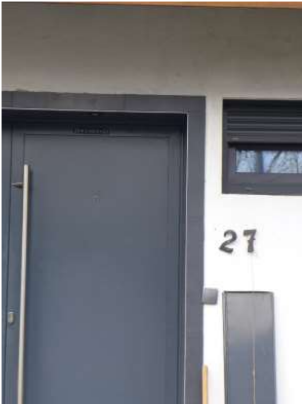
7 a Eingangstür, nicht montierte Fensterbank
