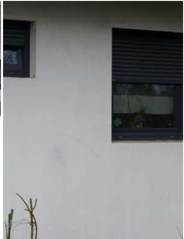
7 b Fassade, nicht montierte Fensterbank
