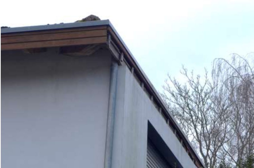
9 nicht ausreichender Dachüberstand an der Westfassade
