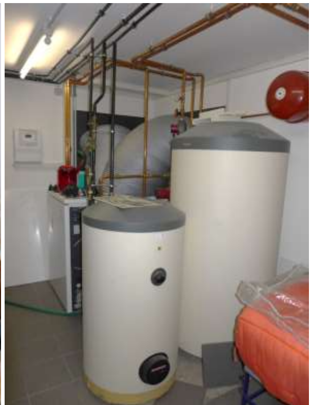
16 b Heizung (Wärmepumpe)
