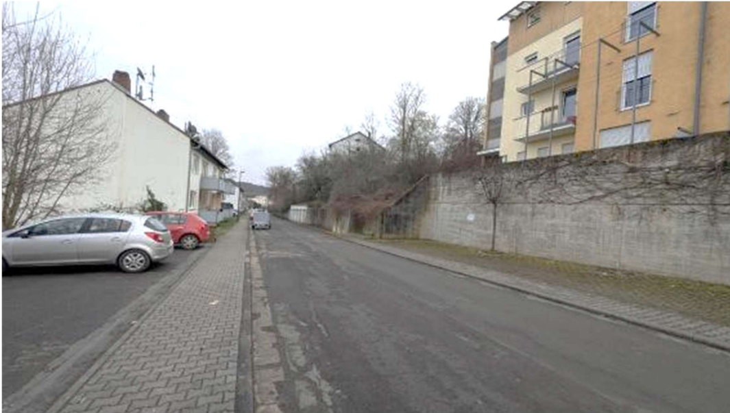
Bild A1 Blick in die Erschließungsstraße
