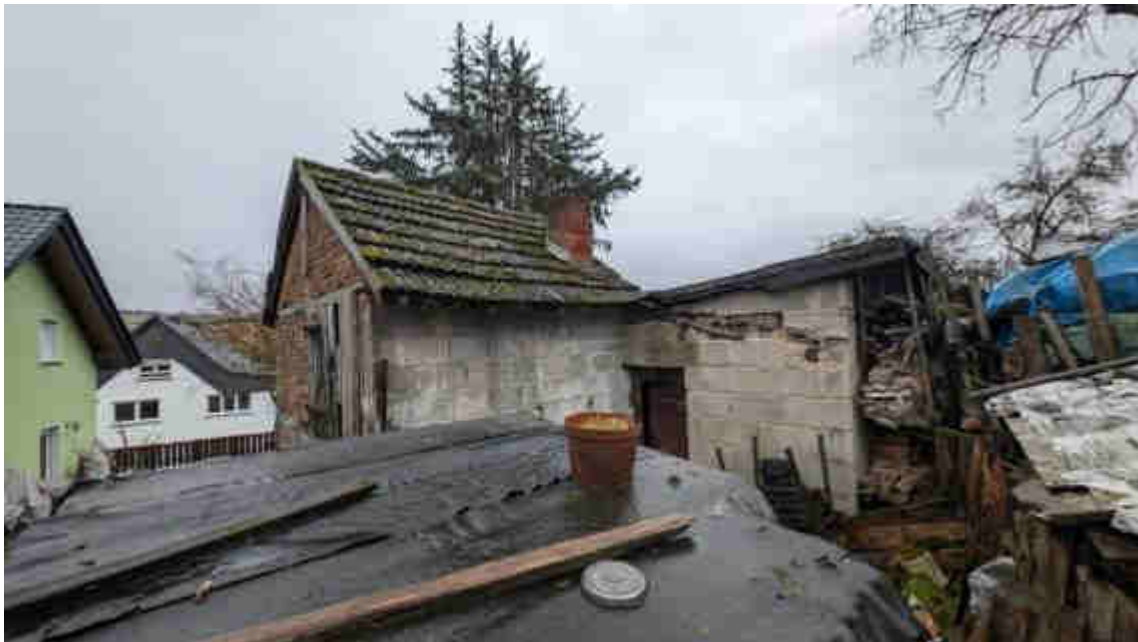
Bild B7 exemplarische Ansicht Nebengebäude
