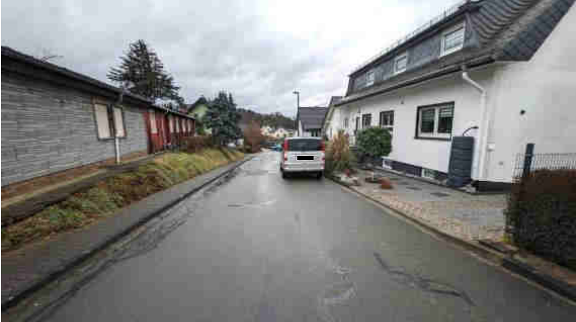
Bild A1 Blick in die Erschließungsstraße
