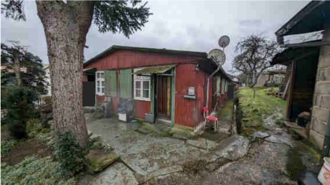
Bild B3 exemplarische Wohnhausansicht
