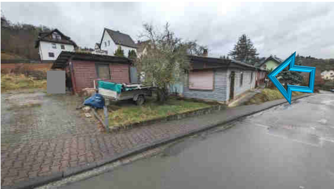
Bild B2 exemplarische Wohnhausansicht
