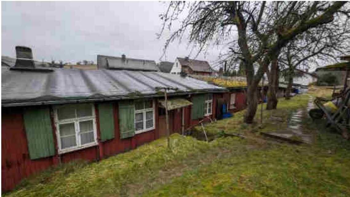
Bild B5 exemplarische Wohnhausansicht
