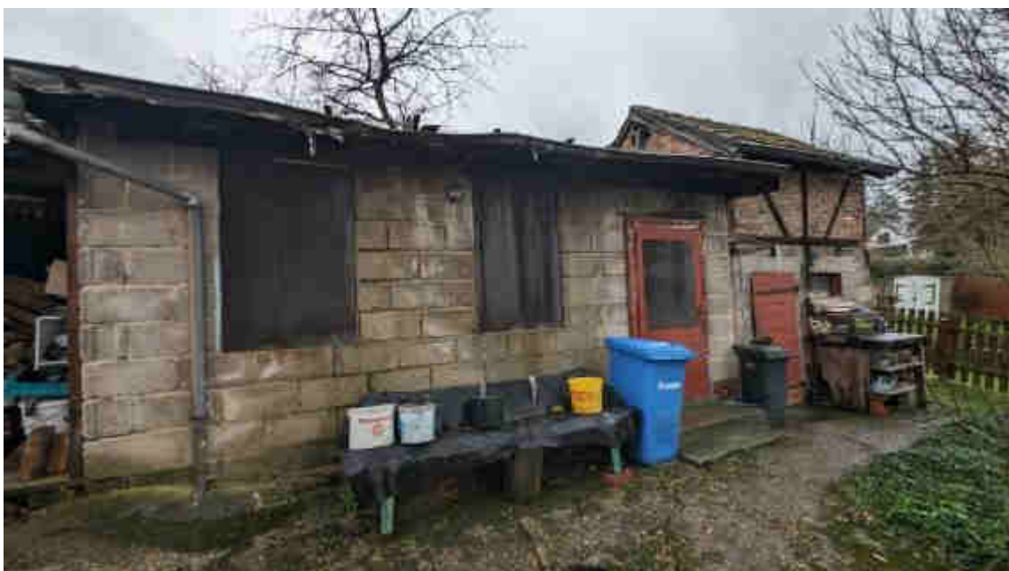
Bild B6 exemplarische Ansicht Nebengebäude
