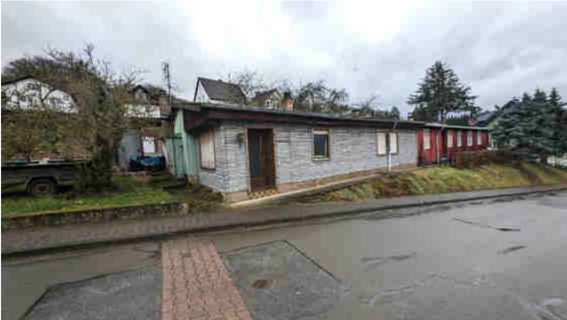
Bild B1 exemplarische Wohnhausansicht
