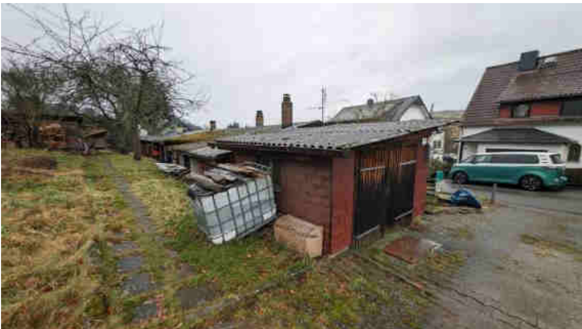
Bild B4 exemplarische Wohnhausansicht
