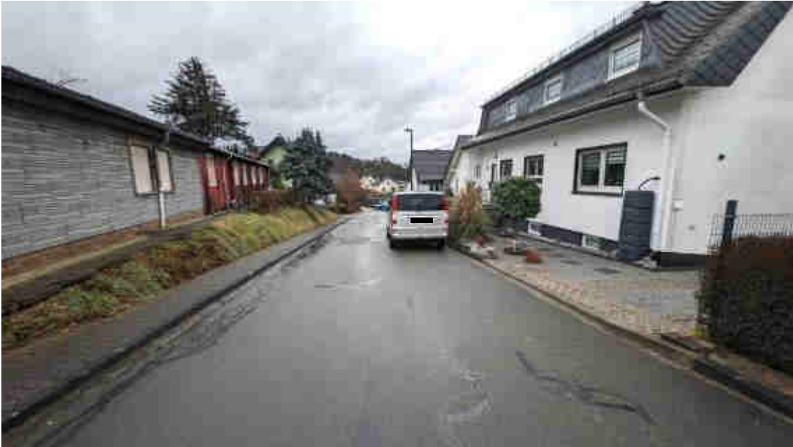
Bild A1 Blick in die Erschließungsstraße
