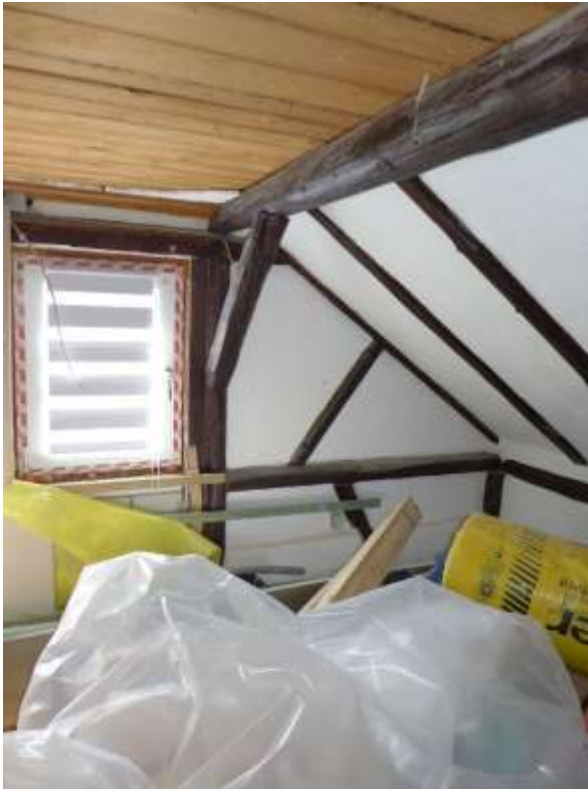
17 a Zustand Dachausbau
