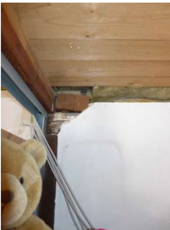
18 a Zustand Dachausbau
