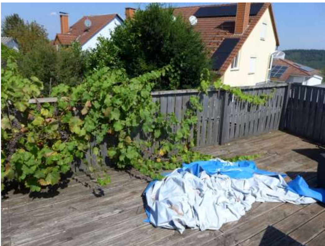
10 aufgeständerte Terrasse hinter Nebengebäude
