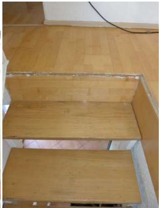
14 b Treppe zum Obergeschoss
