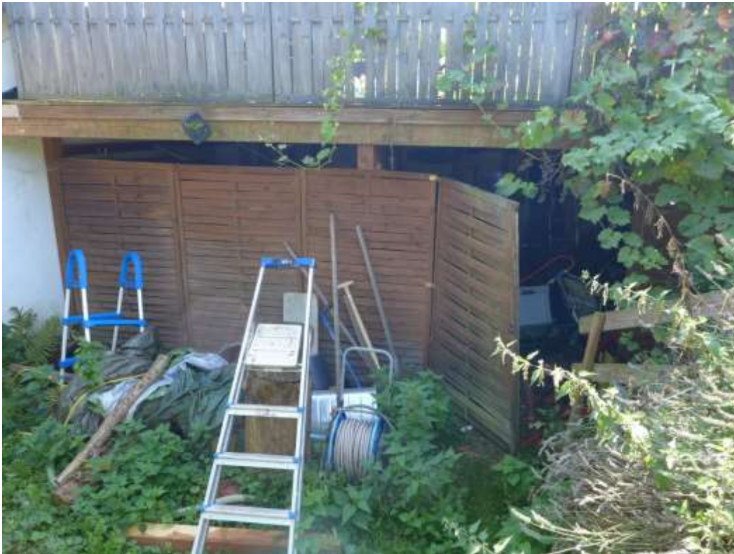
9 aufgeständerte Terrasse hinter Nebengebäude
