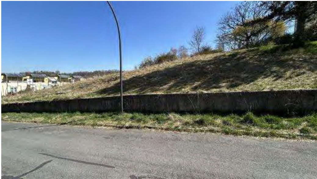
Bild B9 exemplarische Grundstücksansicht Flurstück 234/10
