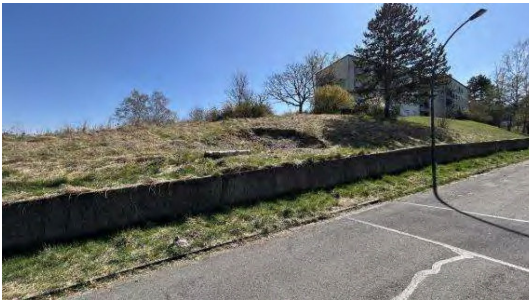
Bild B10 exemplarische Grundstücksansicht Flurstück 234/10
