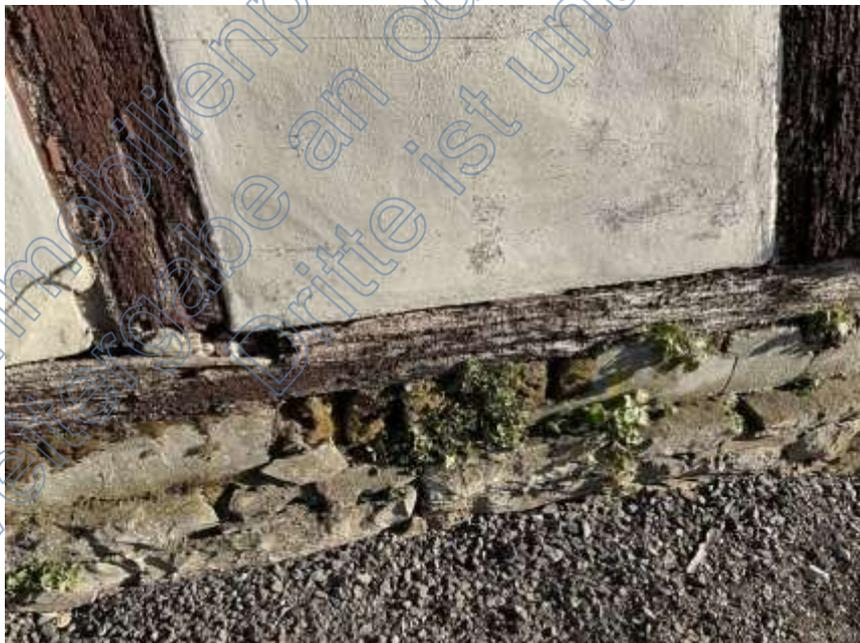
Bild 24: Fundament aus Bruchstein – Schäden am Fachwerk
