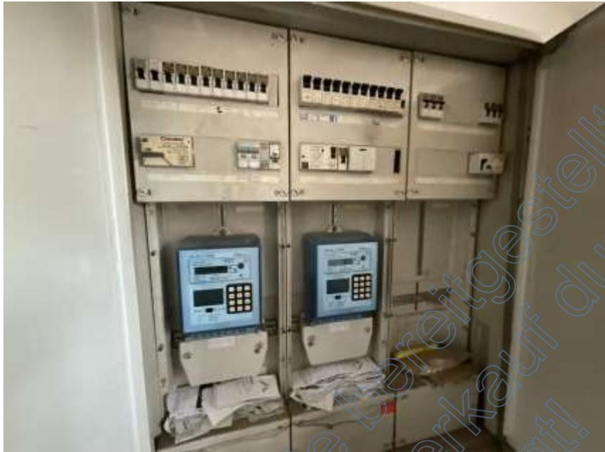
Bild 25: Stromverteilung mit Prepaymentsystem-Zähler
