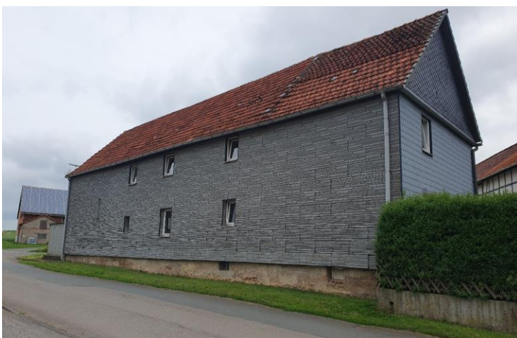
Bild 3 | Ansicht von Südwesten
