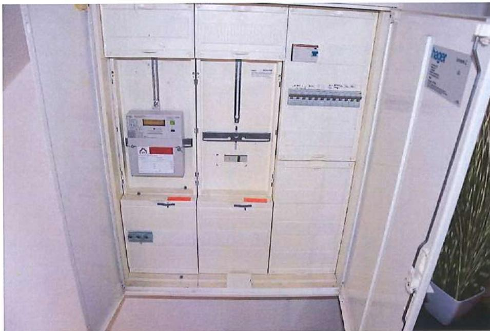
Bild 14: Innenansicht EG Hauptverteilung Strom ohne Funktion
