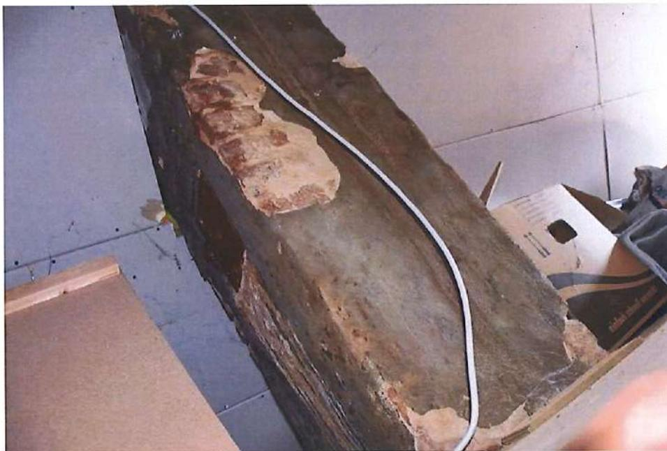
Bild 26: Innenansicht DG - Spitzboden Schornstein versottet
