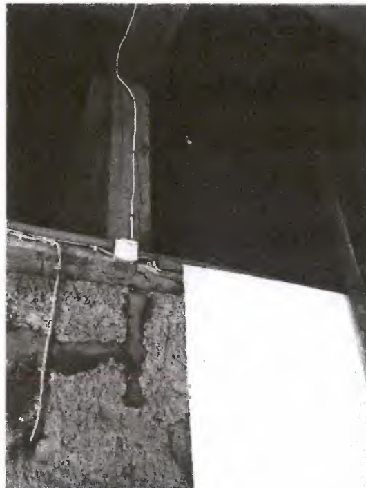
Tennenraum, Blick nach oben
