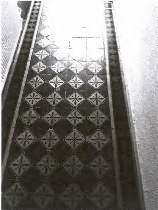
Bauzeitlicher Bodenbelag im Flur
