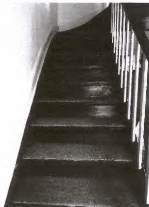
Treppe vom Erdgeschoss zum Obergeschoss
