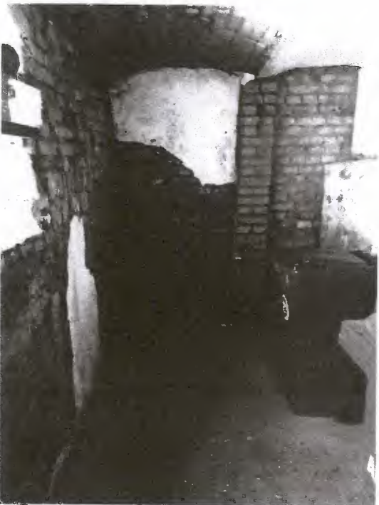
Linkes Gebäudedrittel: Abstellraum
