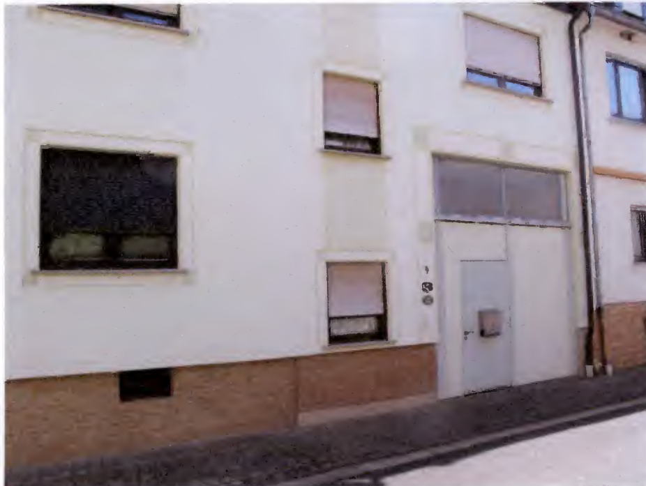
Foto Nr. 04: Ansicht von Alte Straße Blickrichtung Nord-Osten
