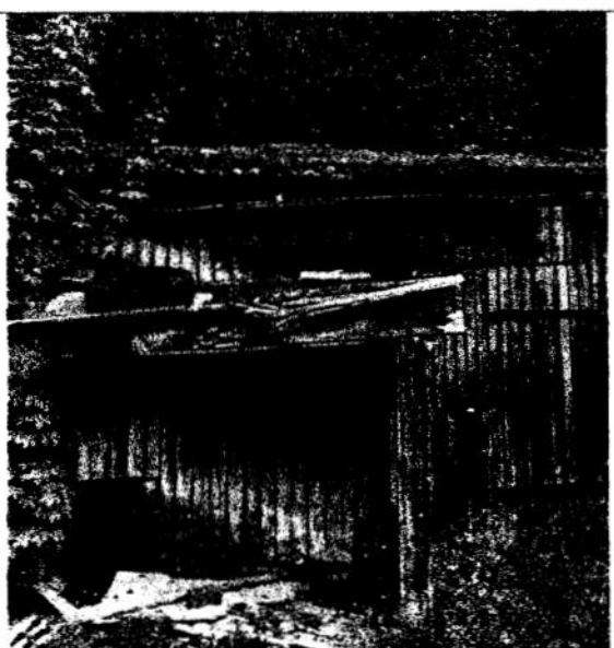
Seiten Gebäude Schuppen. Außen Lattenwände. Dacheindeckung mit Faserzementplatten
