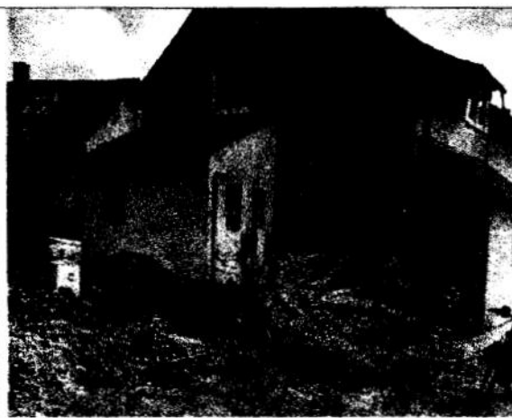
Fenster sind nur tlw. mit zweifach Kunststofffenster ersetzt worden, siehe oben. Fallrohre und Rinnen sind zum Teil defekt.
