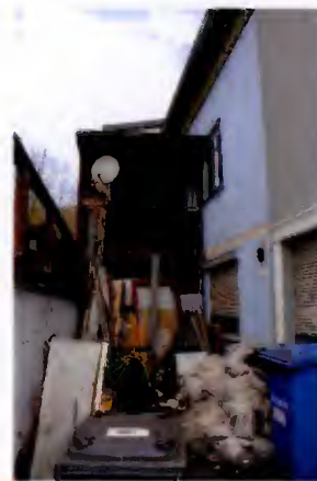
linke Gebäudeseite m. Anbau
