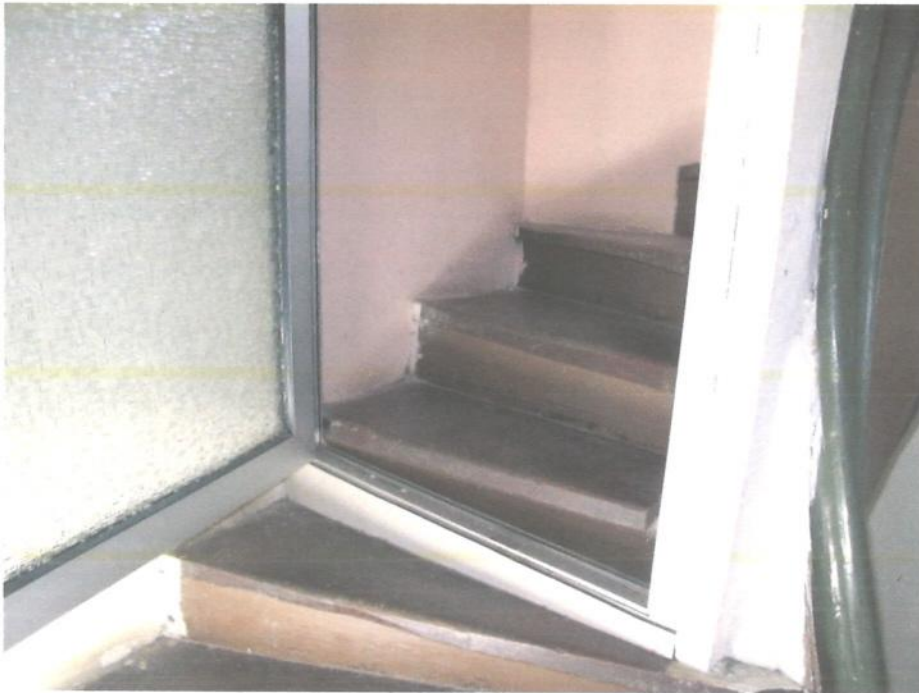
Foto Nr. 33: Wohnhaus, OG, Treppenhaus
