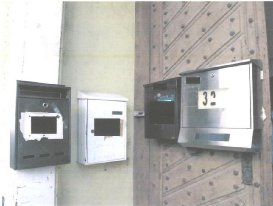
Foto Nr. 09: Hauseingang Borngasse, Detail Briefkästen
