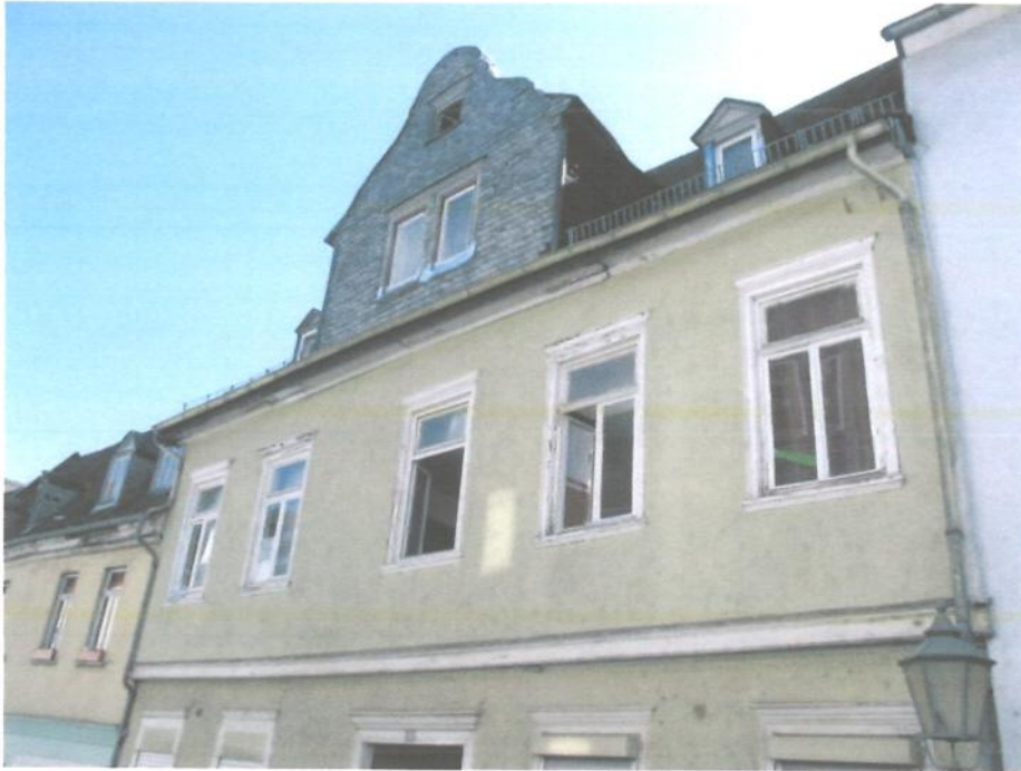
Foto Nr. 07: Ansicht von Borngasse Blickrichtung Nord-Osten
