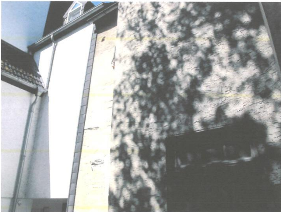
Foto Nr. 16: Ansicht von Rückseite Blickrichtung Süd-Westen
