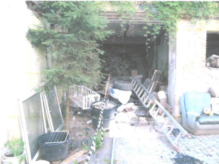
Foto Nr. 22: Ansicht restliches Nebengebäude von befestigter Freifläche Blickrichtung Osten
