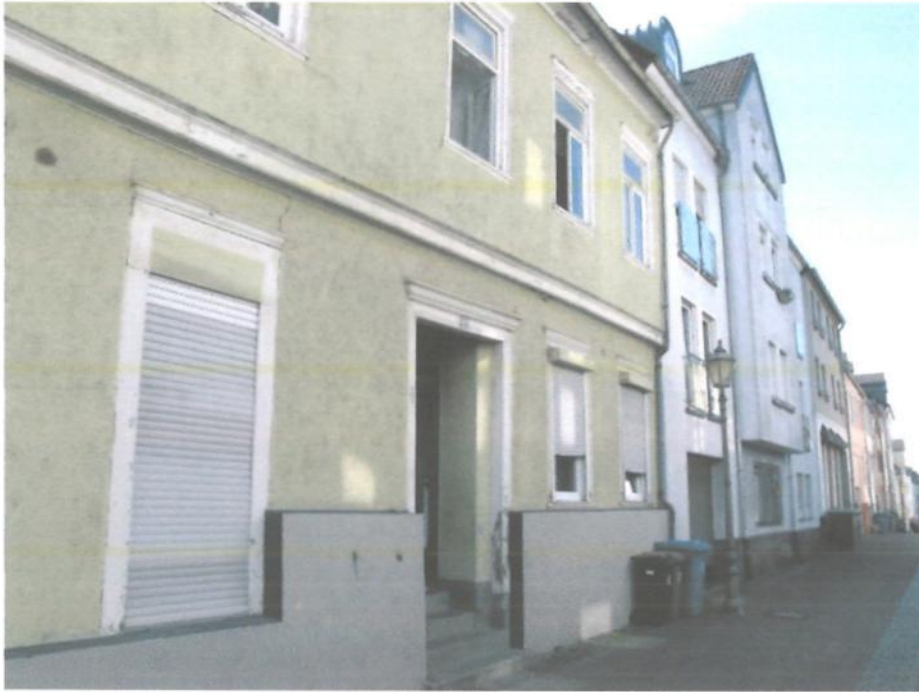
Foto Nr. 03: Ansicht von Borngasse Blickrichtung Süd-Osten
