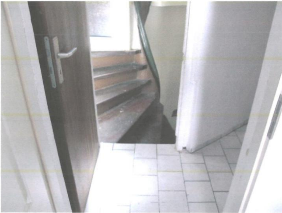
Foto Nr. 29: Wohnhaus, OG, Flur und Wohnungseingang
