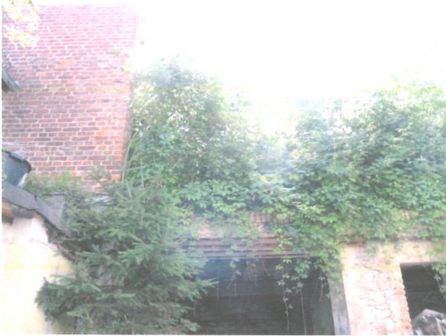
Foto Nr. 21: Ansicht restliches Nebengebäude von befestigter Freifläche Blickrichtung Osten
