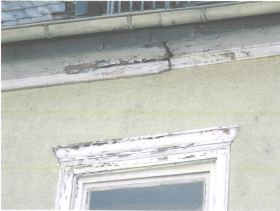
Foto Nr. 11: Ansicht von Borngasse, Detail Traufüberstand
