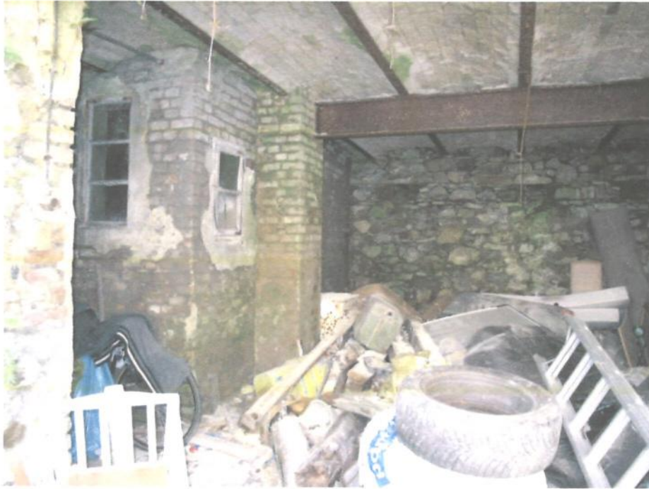
Foto Nr. 23: Innenansicht restliches Nebengebäude, Garage
