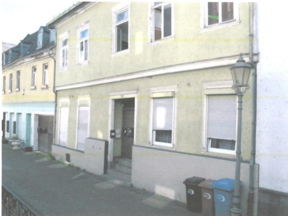
Foto Nr. 06: Ansicht von Borngasse Blickrichtung Nord-Osten
