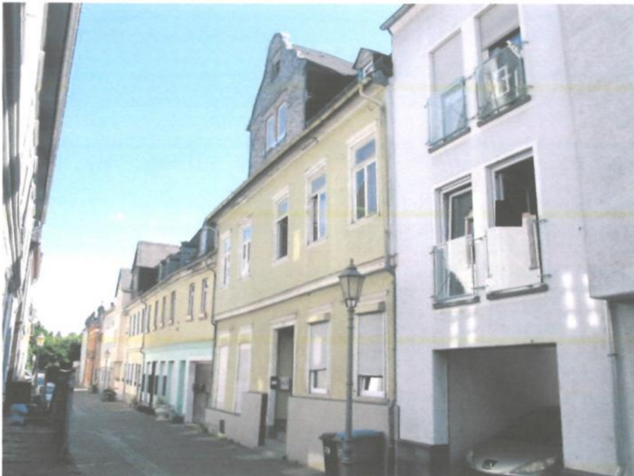
Foto Nr. 04: Ansicht von Borngasse Blickrichtung Nord-Osten
