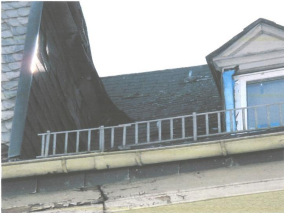
Foto Nr. 10: Ansicht von Borngasse, Detail Dachdeckung, Gaubenverkleidung
