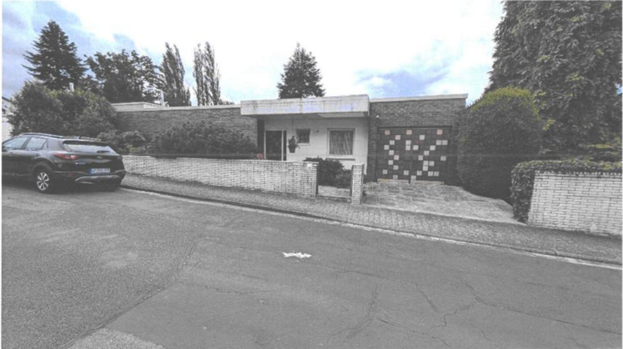
Bild B1 Straßenansicht
