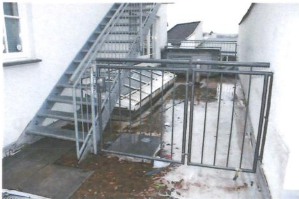
Bild 17: Stahltreppe zum Dachgeschoss
