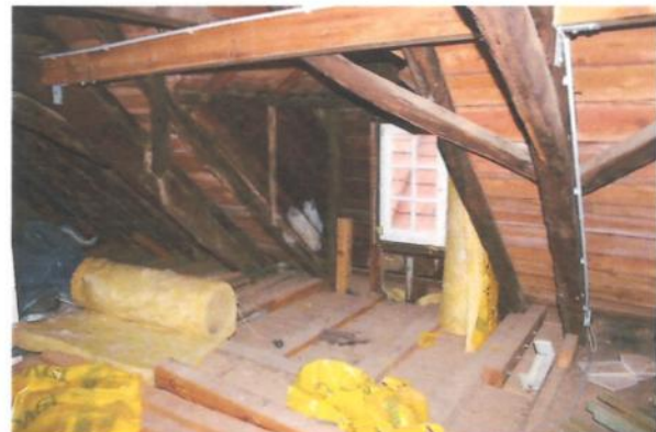
Bild 24 Dachraum denkmalgeschütztes Gebäude
