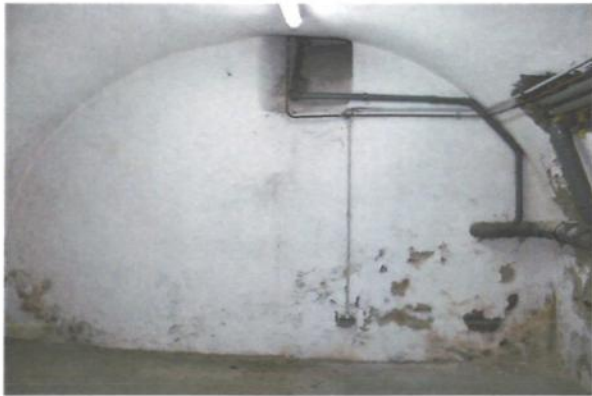
Bild 25: Gewölbekeller denkmalgeschütztes Gebäude
