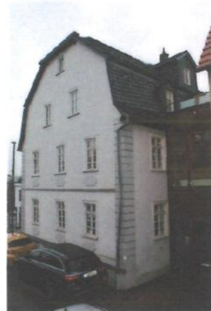
Bild 4: Ost-Ansicht denkmalgeschütztes Gebäude
