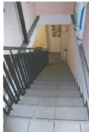
Bild 12: Treppe zum Untergeschoss
