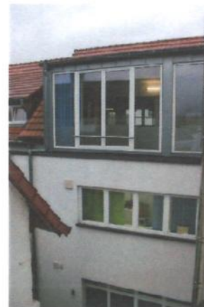
Bild 6: Fassade zum Innenhof
