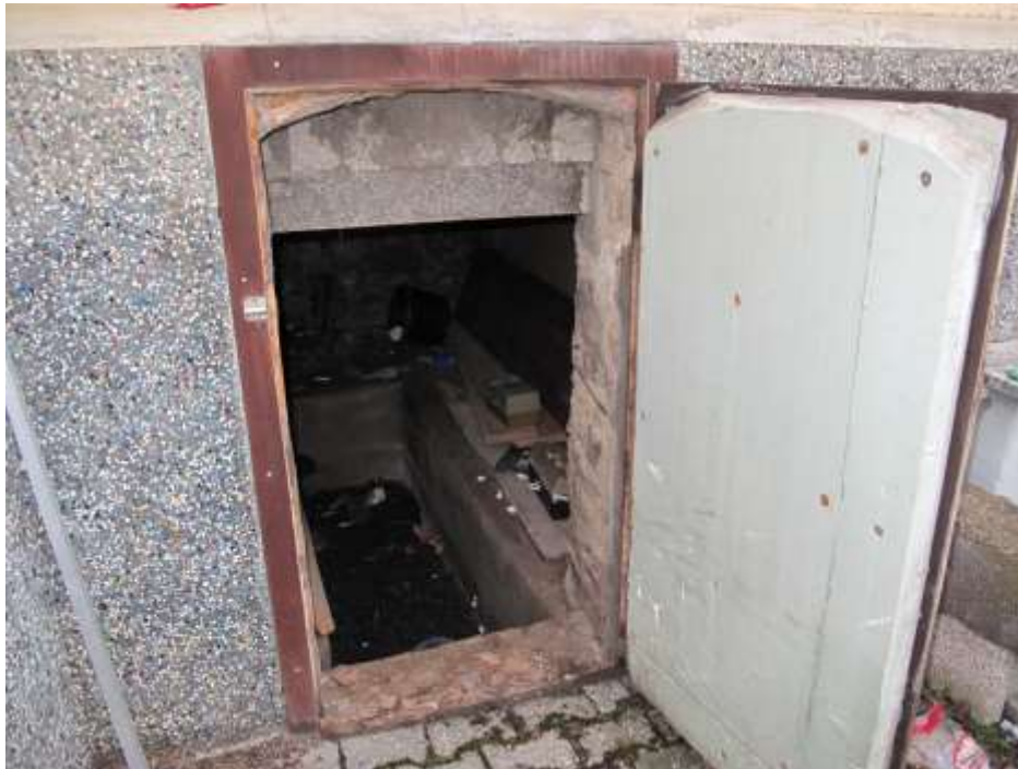
Foto Nr. 33: EG, Zugang Kriechkeller
