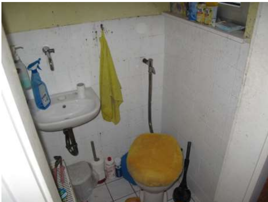
Foto Nr. 18: EG, WC
