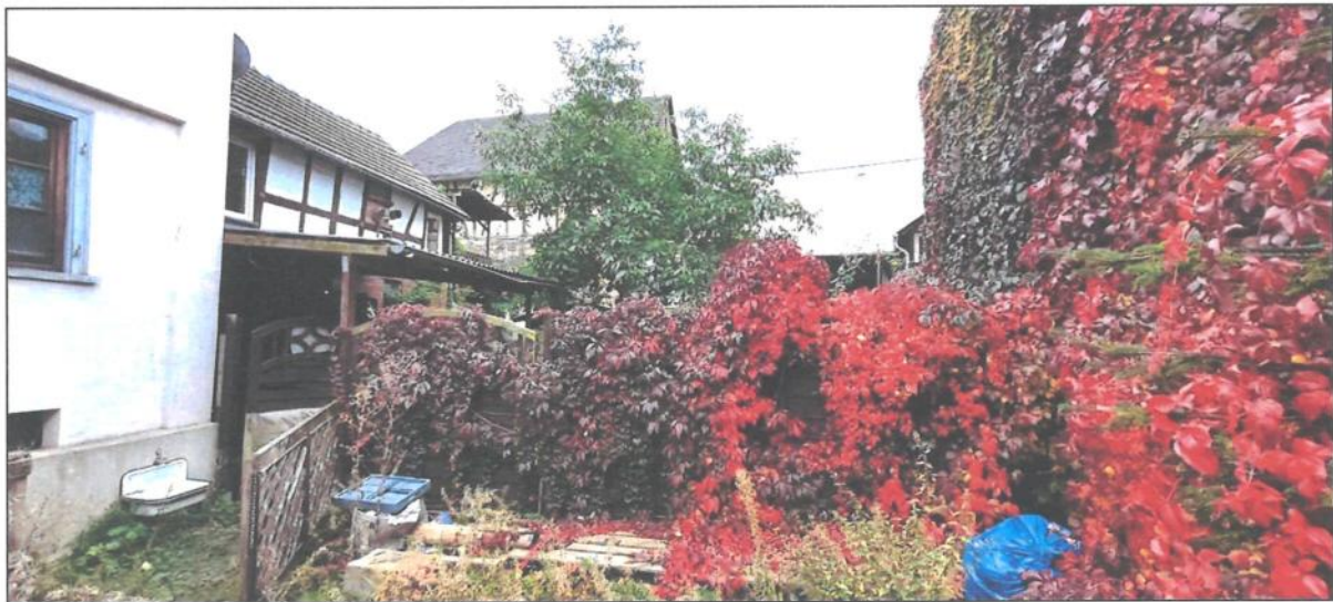
Bild B8: Ansicht Hof / Freifläche
